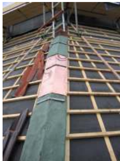
Bild 8: Utbytt plåt på fallande nock över koret.
