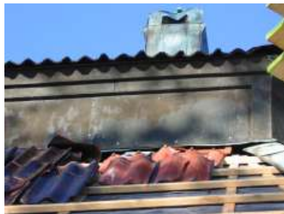
Bild 10: Italianens plåt har kompletteringsfästs.
