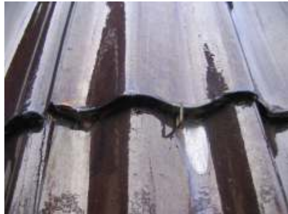
Bild 6: Hål för spik på nedersta pannans övre mitt.
