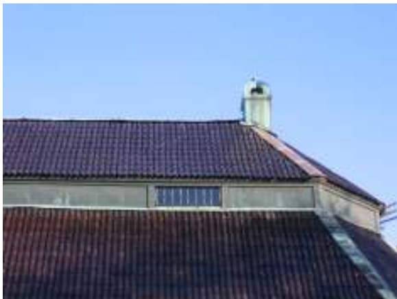
Bild 15: Ny plåt på fallande nock, sydost.
