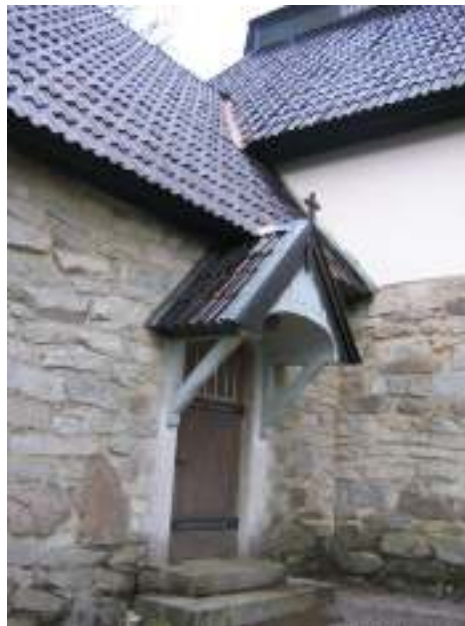
Bild 18: Sakristians skärmtak har kompletterats med ny kopparplåt.
