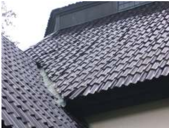
Bild 5: Sakristians rännadal på västra sidan.
