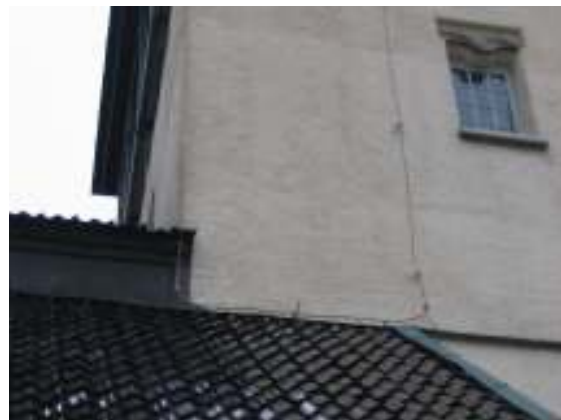
Bild 22, th: Komplettering av åskskydds- ledaren.
