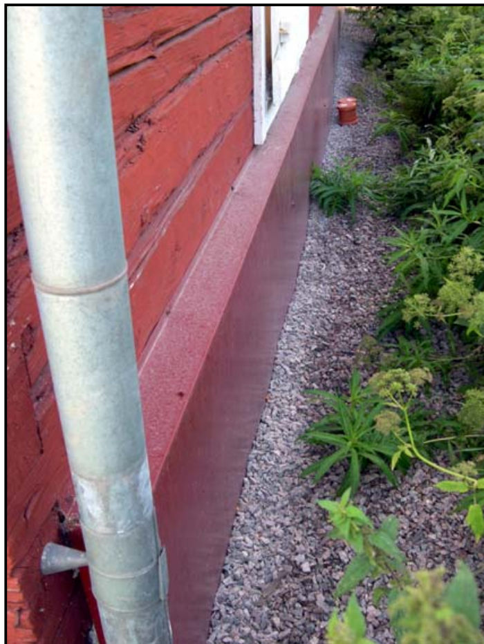
Plåtkonstruktion mot västfasad, OLM_2008_26_13
