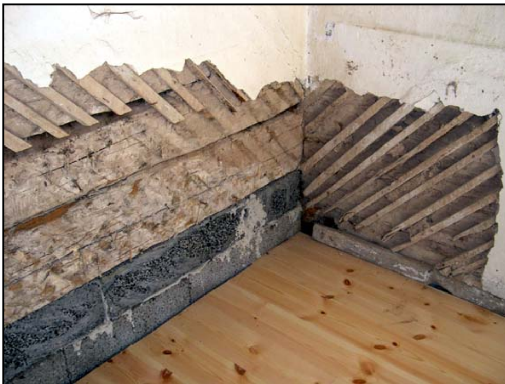
Lecablock istället för svampangripen timmerstock, OLM_2008_26_10
