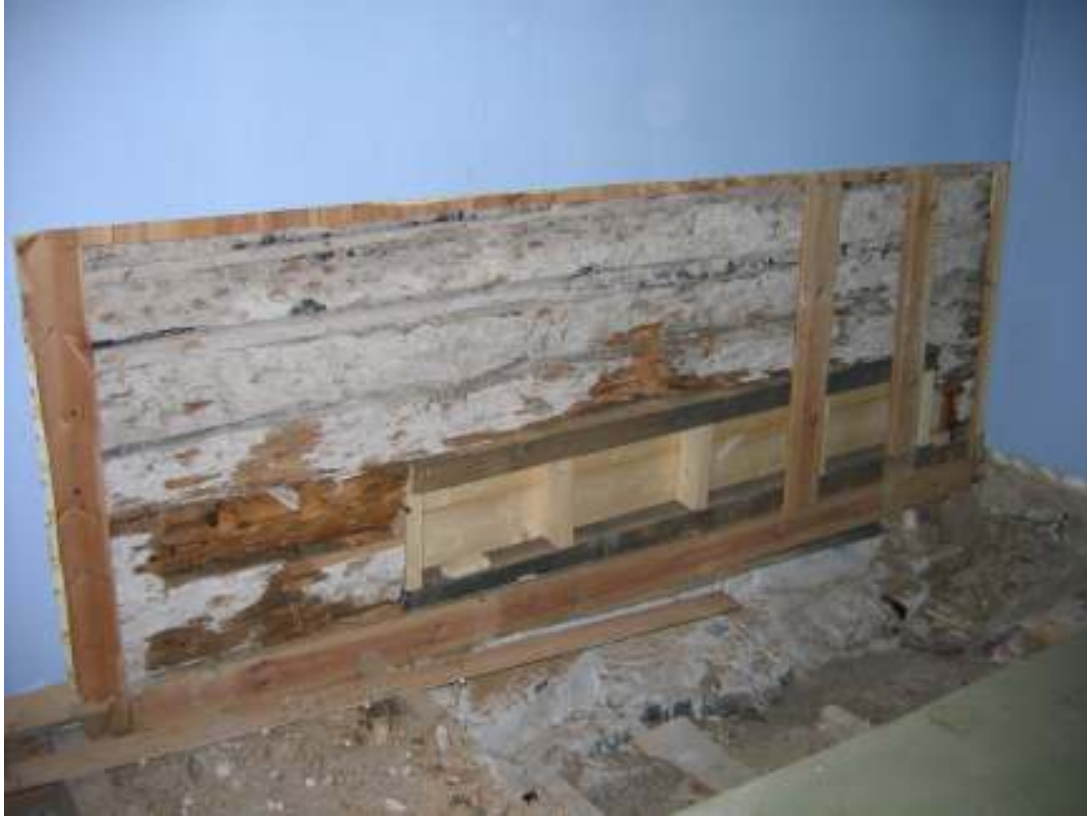
Lagning av timmerstomme i det större rummet.
