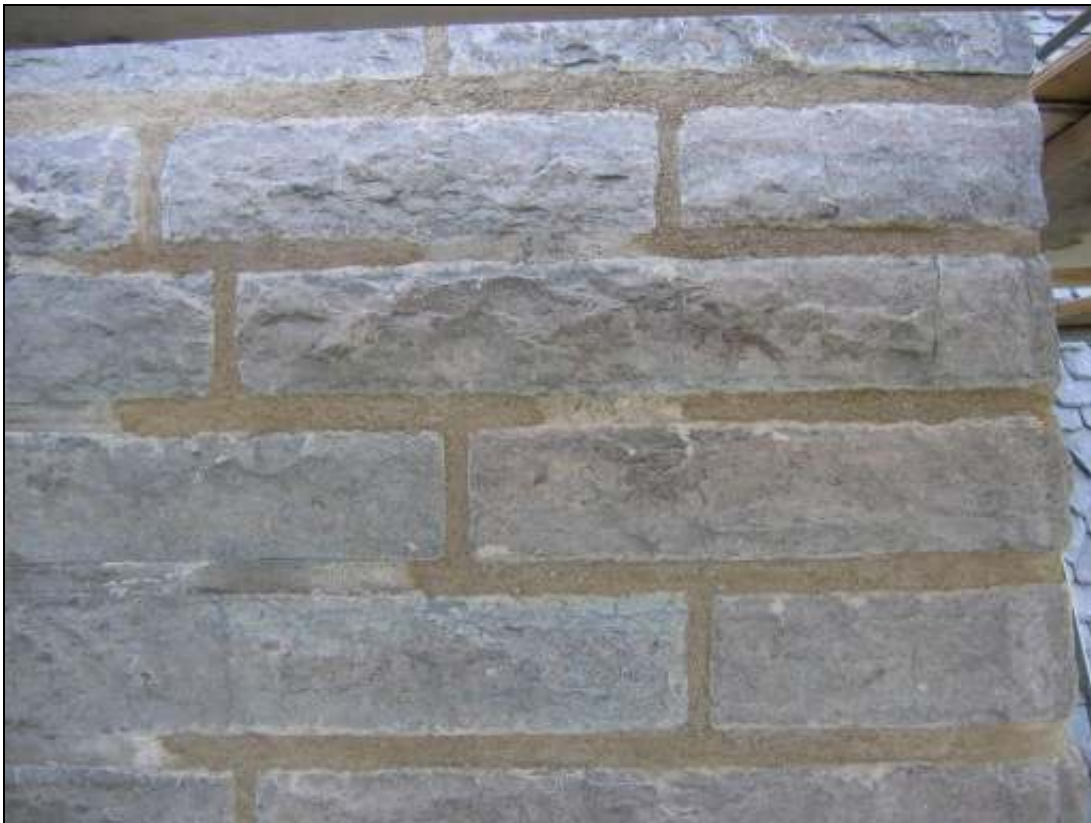
Fasad med nytt och äldre fogbruk
