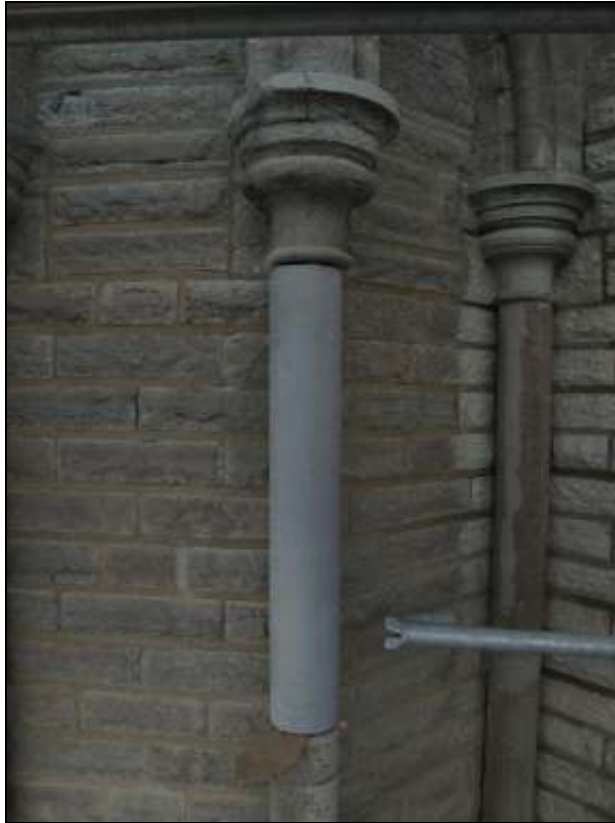
Lagning av kolonn pågår
