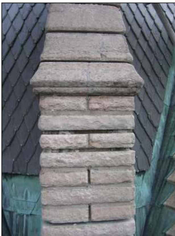
Fogarna har rensats från löst sittande bruk
