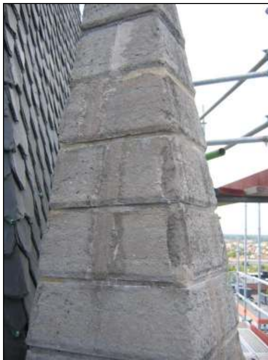
Pigmentering av stenlagningsbruk pågår
