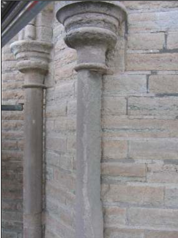
Halva kolonnkäftet är borta
