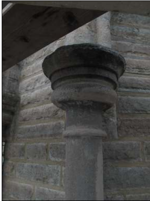
Del av kolonn efter åtgärd
