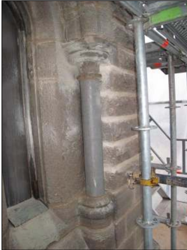
Kolonn efter åtgärd
