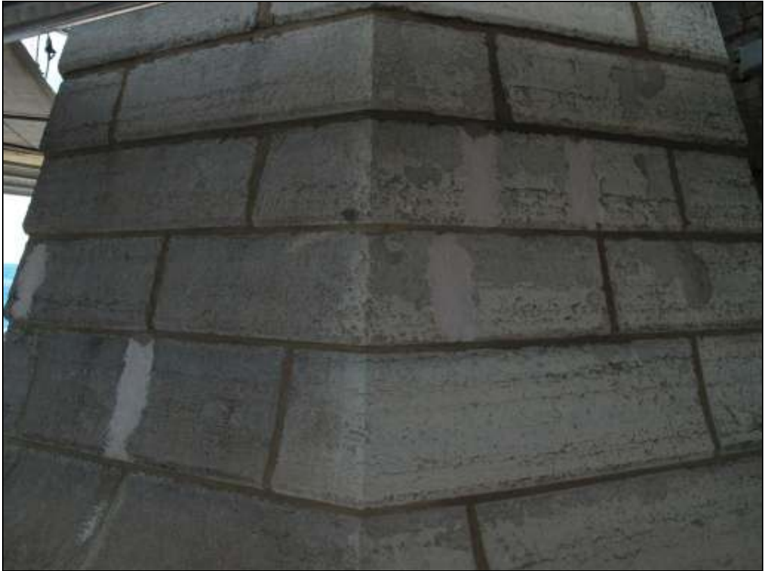
Fasaden är omfogad och sprickorna är lagade med stenlagningsbruk
