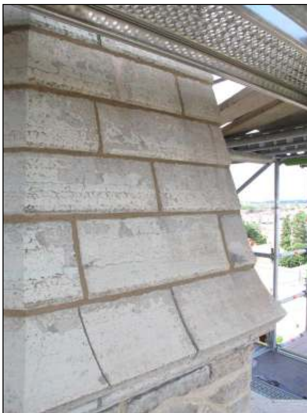
Fasad efter omfogning
