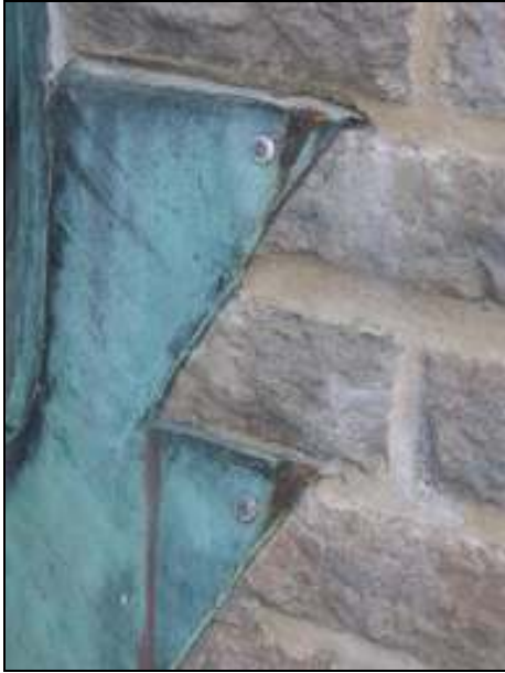
Plåt är monterad med rostfri skruv
