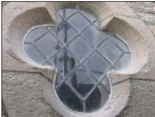
Fyrpass med senare lagning i nederdel
