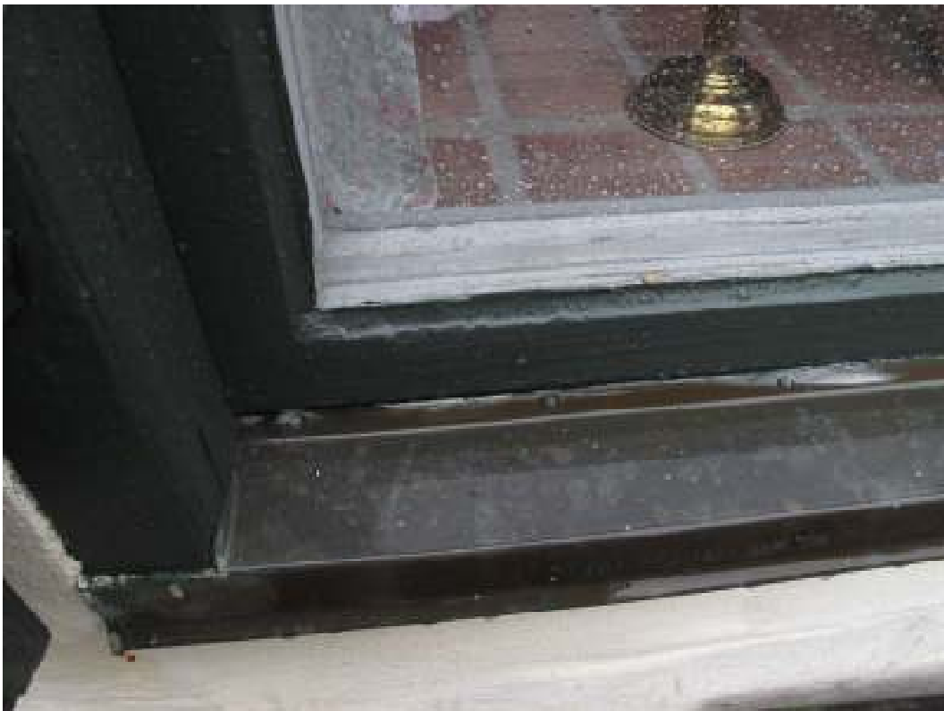
Fönster efter åtgärder.
