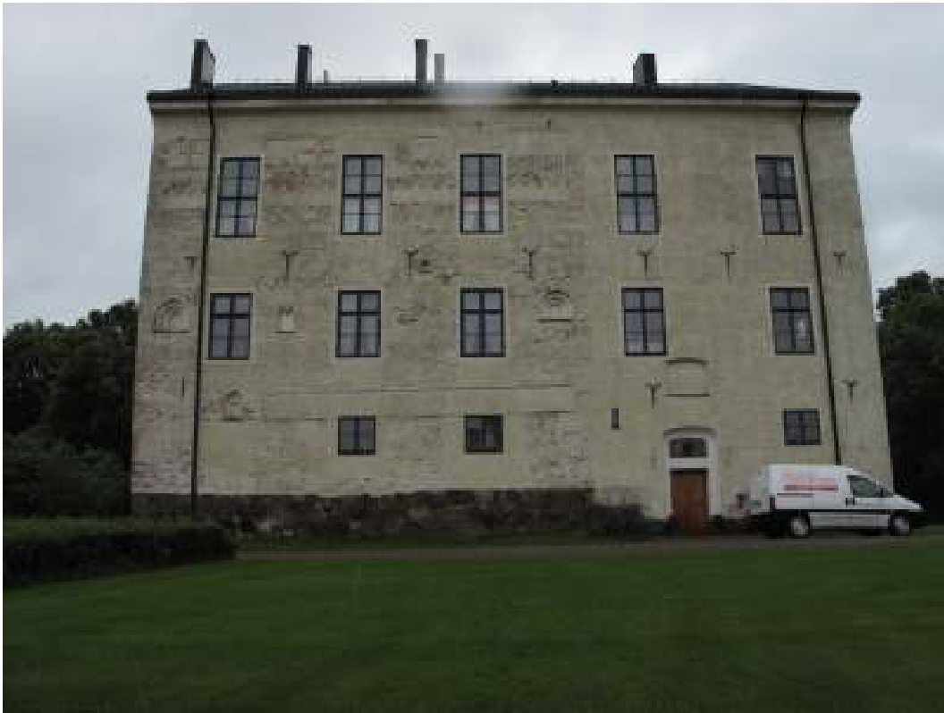
Norra fasaden efter åtgärder.
