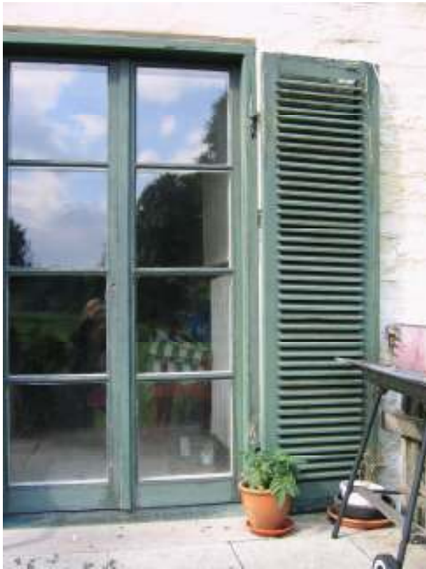
Jalusier och dörr till altan före åtgärder.
