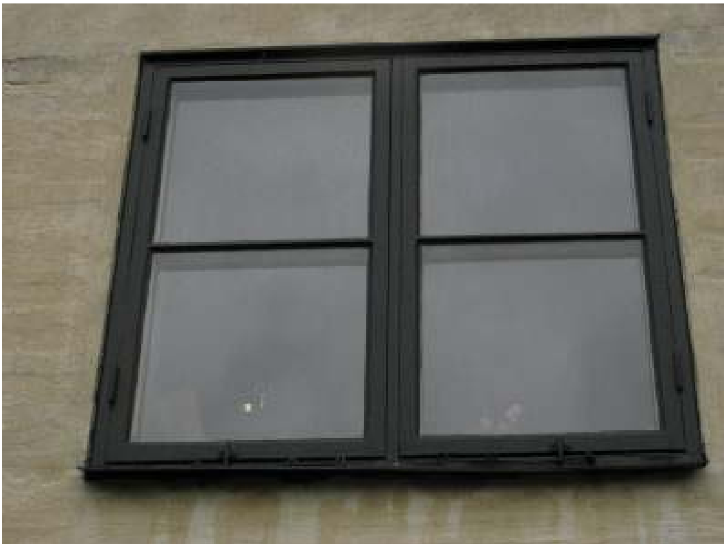
Fönster efter åtgärder.
