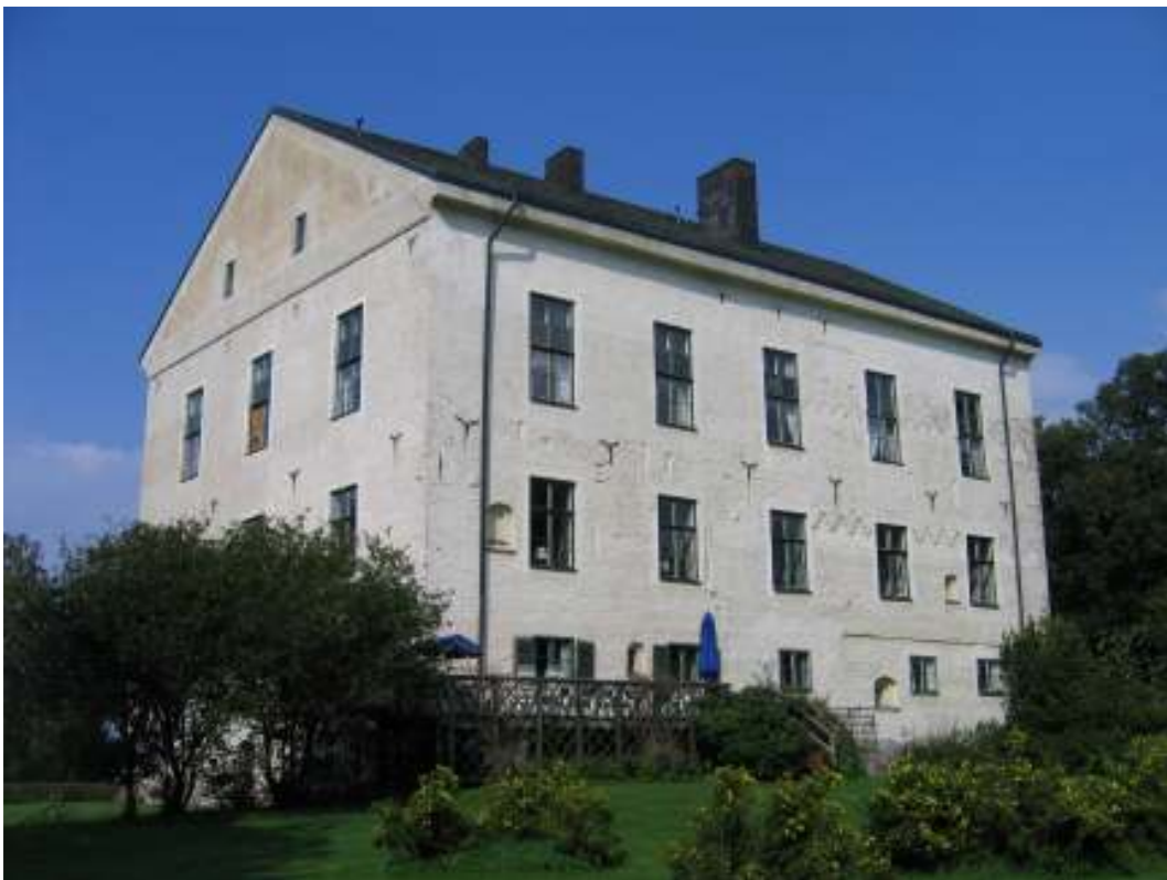
Södra fasaden före åtgärder.
