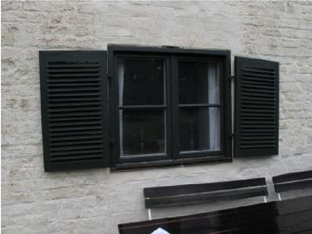
Fönster och jalousier efter åtgärder.
