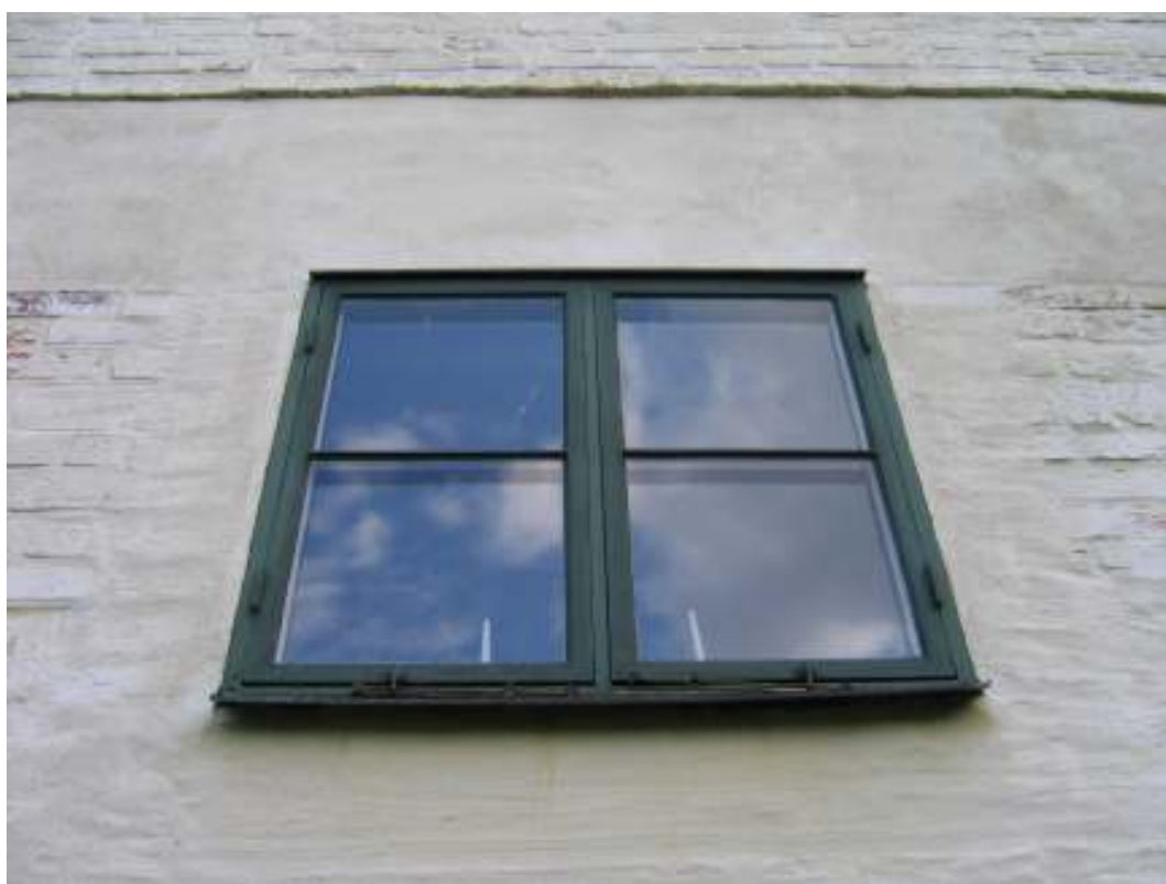
Fönster före åtgärder.
