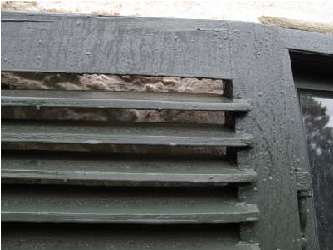
Jalousier efter åtgärder.
