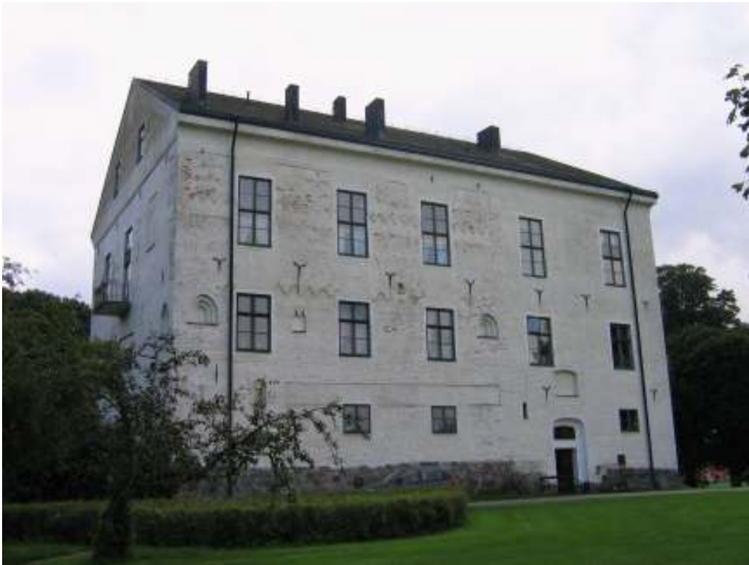
Norra fasaden före åtgärder.
