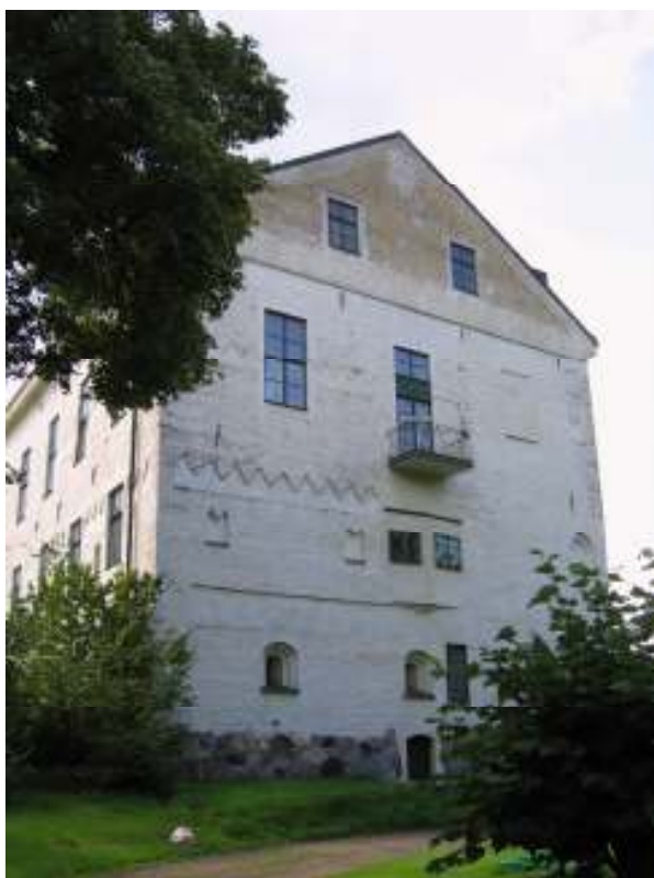
Östra fasaden före åtgärder.
