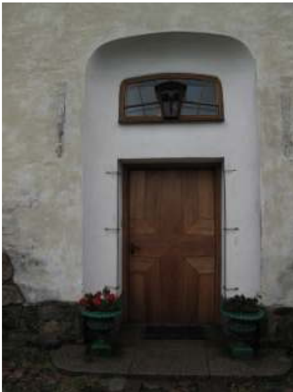
Ytterport med överljus i norra fasaden, före åtgärder.
