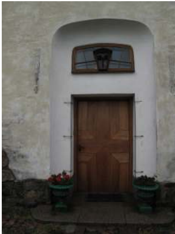
Ytterport och överljus på norra sidan, efter åtgärder.
