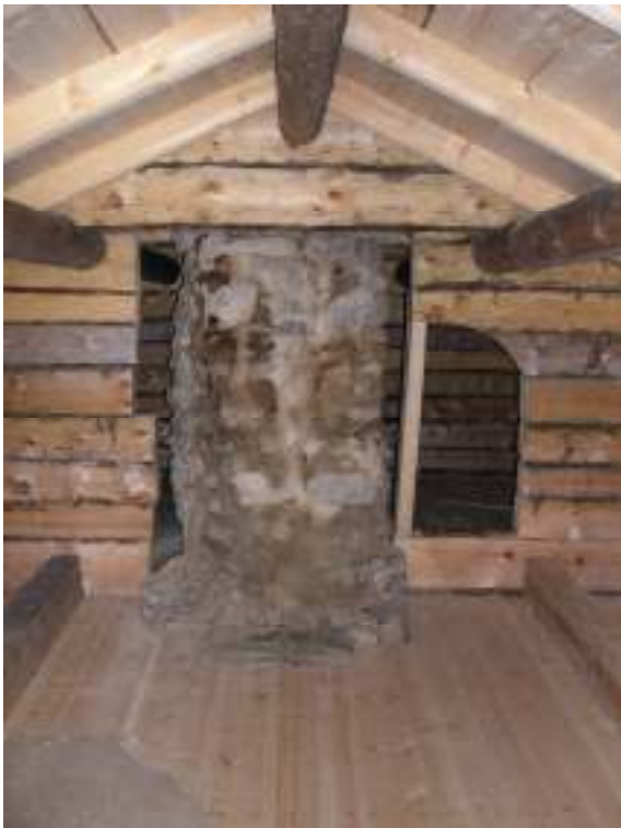
Loftet. Murstocken och det nya golvet.
