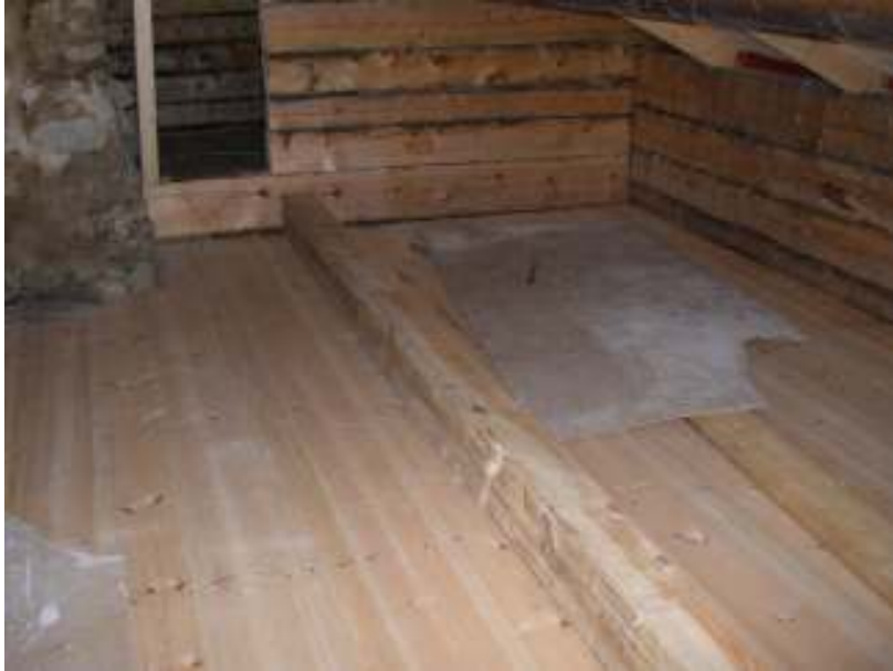
Mellanbjälklaget och det nya golvet.
