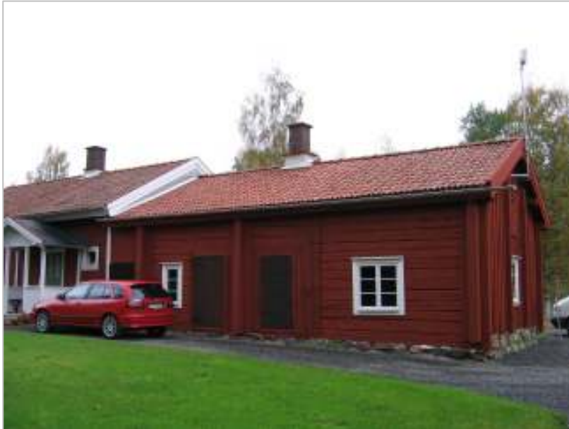
Hus 4 efter renovering.
