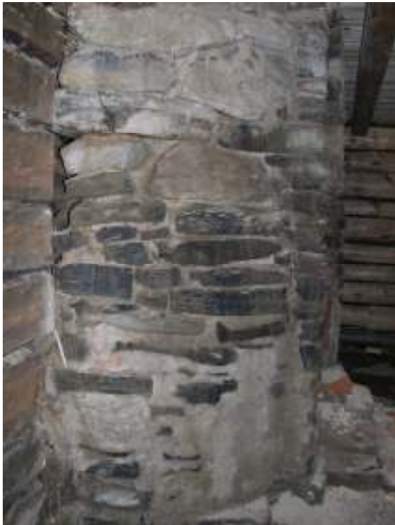
Eldstaden i östra rummet innan den putsades.
