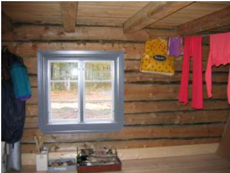
Östra rummet med nytt fönster, fönsterfoder, golv och golvfoder.
