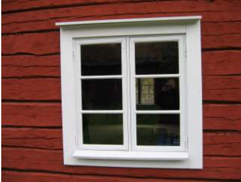
Nyttillverkade fönster och fönsterfoder efter ursprungliga modeller samt uppmättningsritningar.
