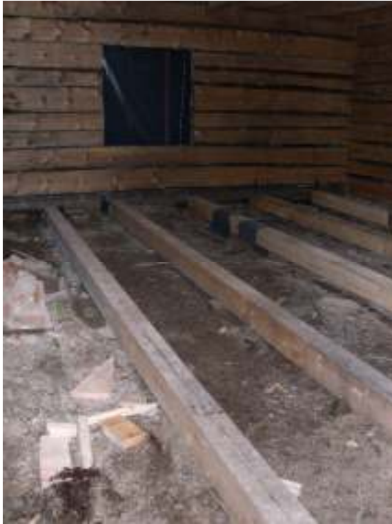
Bottenbjälklaget i östra rummet.
