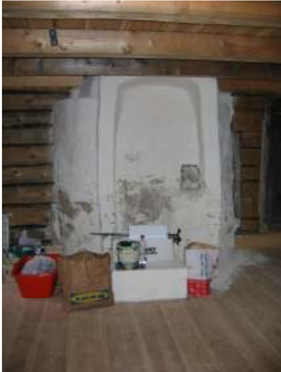
Eldstaden i östra rummet efter åtgärder. Putsen flagar längs ner troligtvis på grund av att murverket suger en del fukt från grunden.
