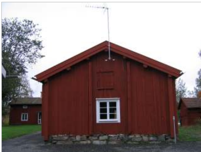
Den panelförsedda östra gaveln.
