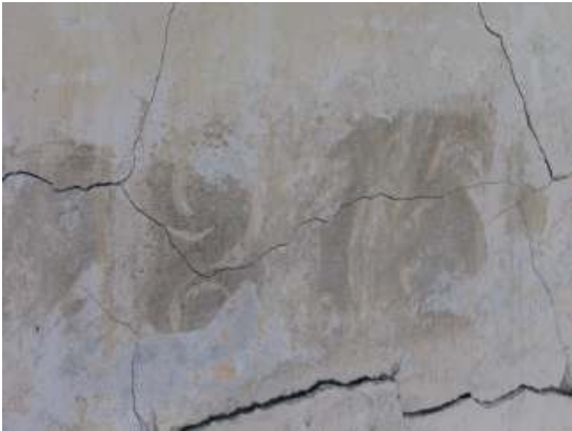
Årtalet, 1857, skrivet på mittrisalitens fasad, före åtgärder år 2006.
