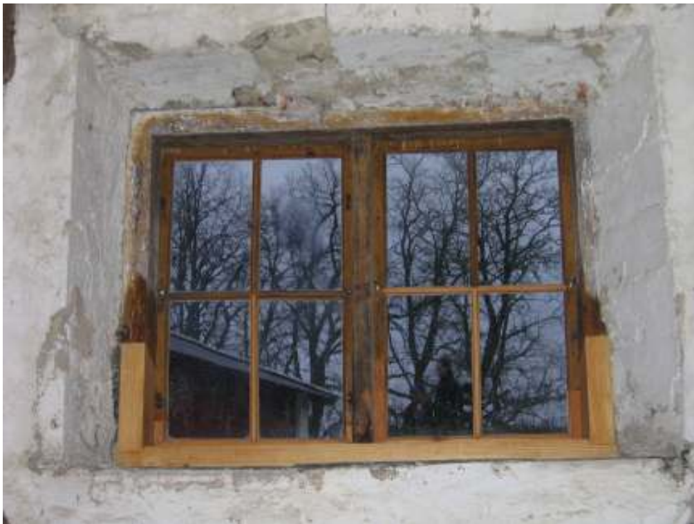
Fönsterbågar och -karmar, exteriört och interiört efter åtgärder år 2006.
