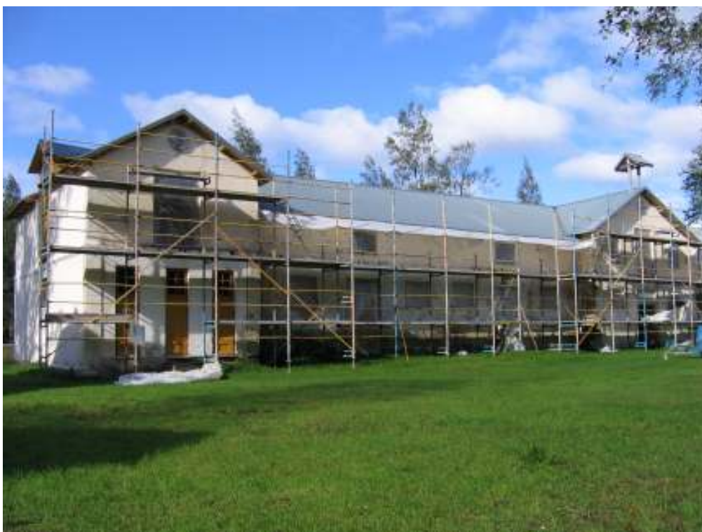
Västra och östra fasaden efter åtgärder, år 2006. Längs västra fasaden stod ställningarna uppe vid slutbesiktningen år 2006 och dörrarna var kvar att montera på plats.
