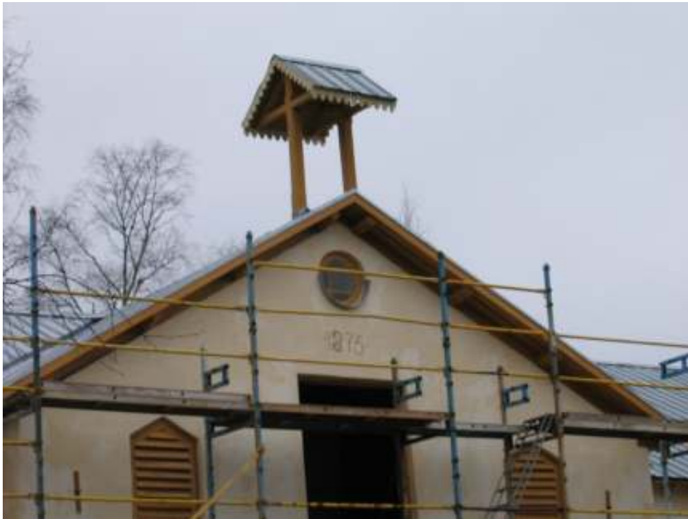
Klockstapeln efter åtgärder, år 2006.
