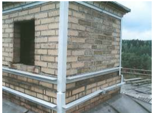
Sammanhållande konstruktion av vinkeljärn på yttermuren
