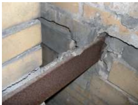
Den yttre muren till höger och den inre, själva murstocken till vänster. Horisontella järnstag var förankrade från sida till sida i det yttre murverket samtidigt som det låg an mot murstocken.
