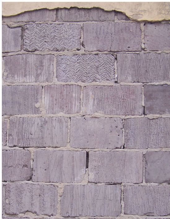
Bild ovan: Driftskontoret i Norra fabriksområdet, Hällabrottet. Byggnaden är uppförd någongång mellan 1937 och 1943. Bild nedan: Bostadshus i Pershyttan, Nora, med spår efter både tandade sågblad och trådsågning i ytstrukturen.
