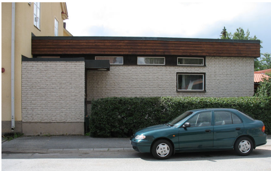
Den första leveransen av mexi gick till en tillbyggnad av ett 1920-talshus i Örebro. Beställningen gjordes 1964 och tillbyggnaden uppfördes 1965. Tillbyggnaden har även invändigt väggar av kalksandsten från Kvarntorp. (Tivenius G (070713))
