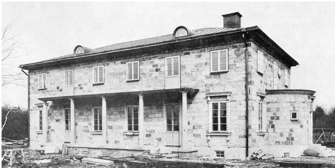
Eriks Carléns disponentvillan i Yxhult. Uppförd 1931-32 efter ritningar av Ragnar Östberg. Här har fönstervalv slagits med lättbetong. Bilden hämtad ur Yxhult II.
