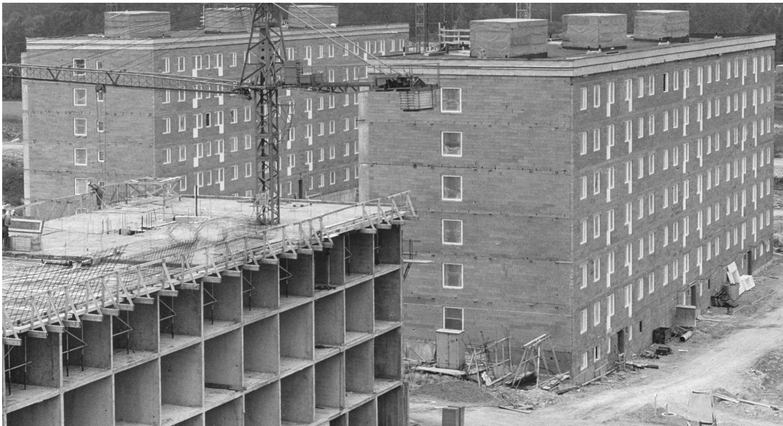
Viggbygårde, byggt 1967-68. Platsgjuten betong med utfackning av limmad Ytongstav. Bild ur Yxhultbygdens kultur- och hembygdsföreningsarkiv.
