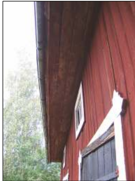
Takfoten före åtgärder.
