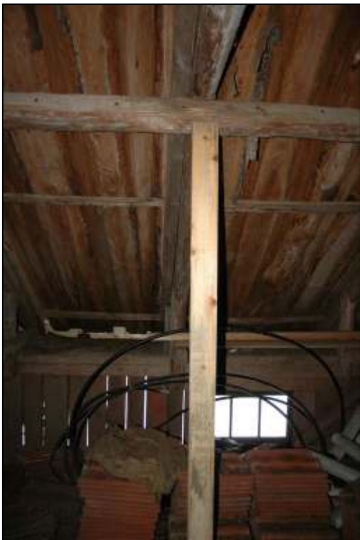
Stolpe på loftet för att stötta upp taket.
