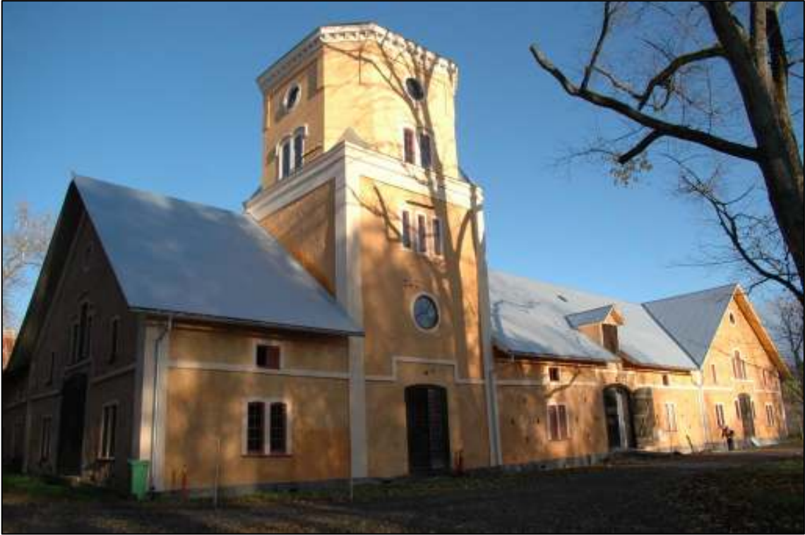
Sydvästra sidan innan åtgärd
