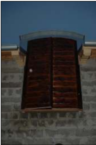
Nyttillverkad skullport, port samt fönster efter åtgärder, sydöstra sidan
