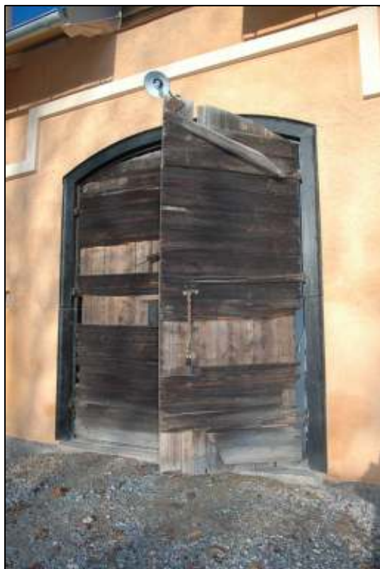
Port på sydvästra sidan före åtgärd
