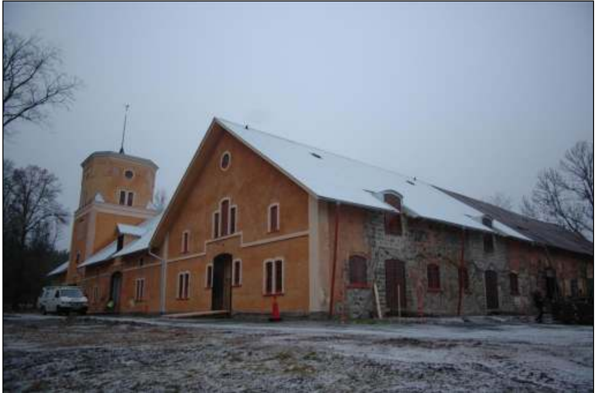
Sydvästra samt sydöstra fasaden Arbetet är nästintill färdigt
