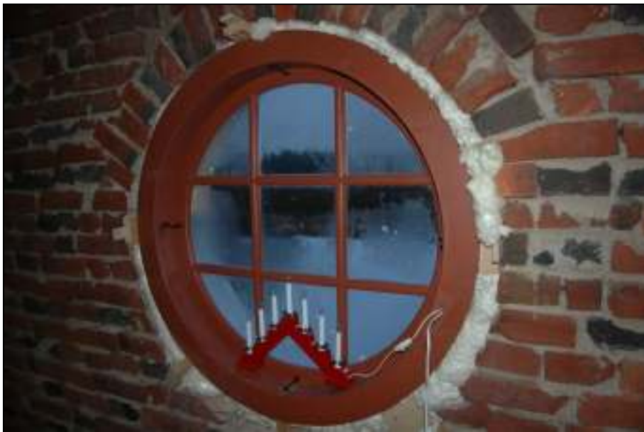
Nyttillverkat tornfönster efter åtgärd
