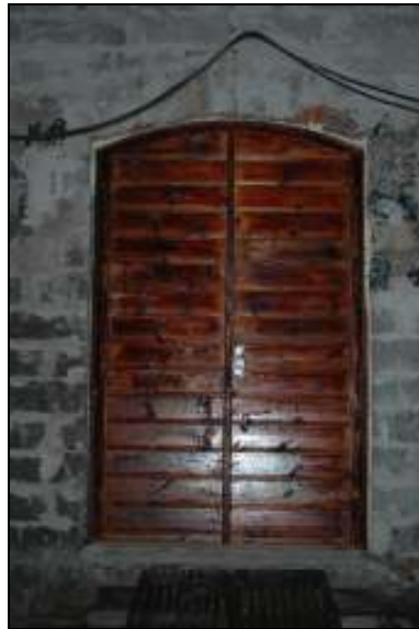
Nyttillverkad skullport, port samt fönster efter åtgärder, sydöstra sidan
