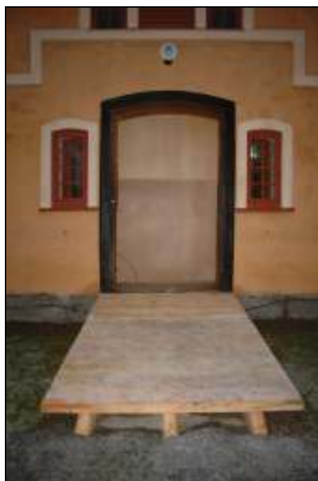
Körbrygga är monterad, arbete med infästning i grund samt behandling med tjära återstår
