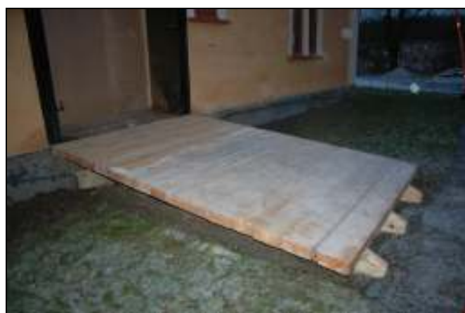
Körbrygga är monterad, arbete med infästning i grund samt behandling med tjära återstår
