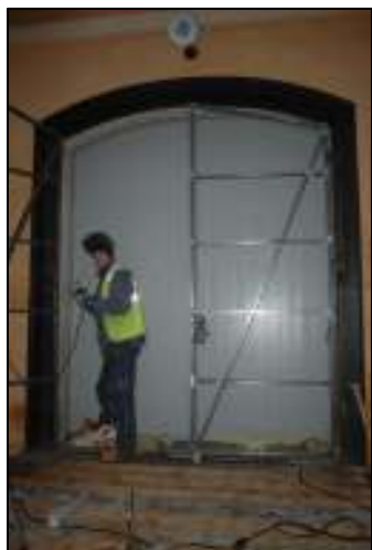
Montering av svetsad stomme på sydvästra sidan pågår
