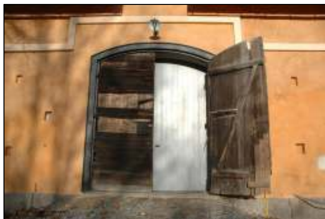
Nya innerdörrar monterades under etapp 2
