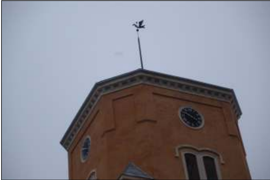
Nyttillverkade urtavlor samt vindflöjel är monterade
