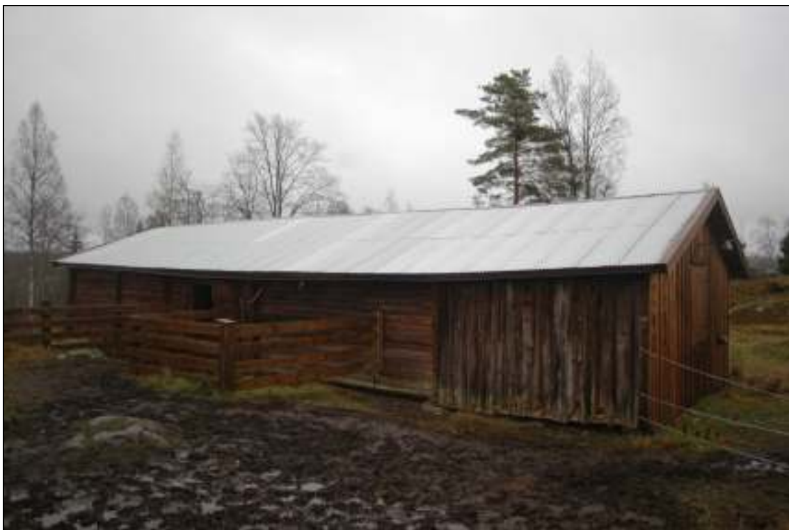
Logens nordöstra takfall har fått ny taktäckning av sinuskorrugerad plåt
