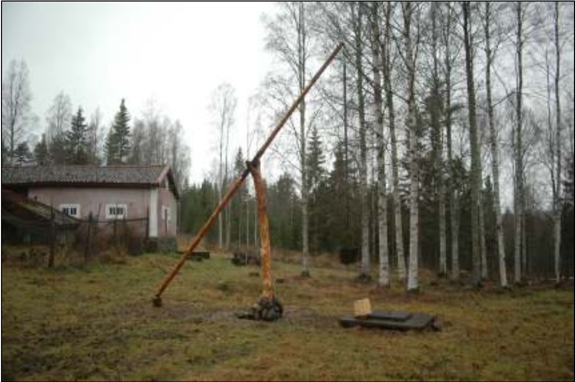
Gårdsbrunnen efter åtgärder
