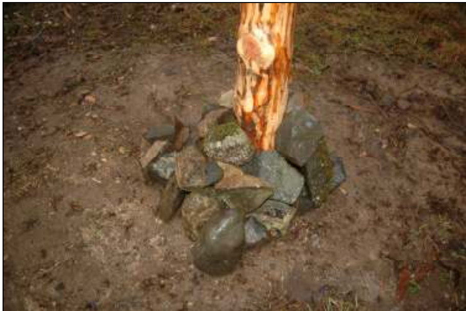
Stolpens förankring i marken, dold av fältsten
