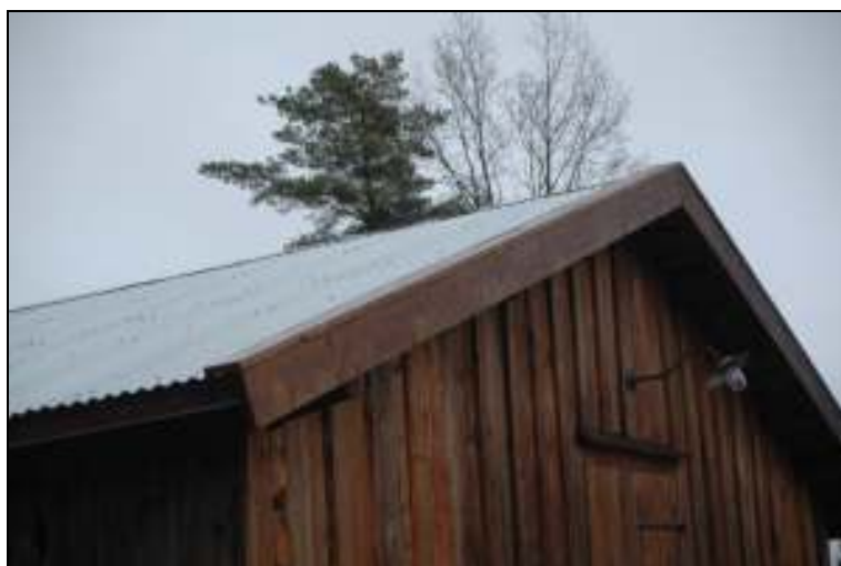
Nya vindskivor samt vattbrädor är behandlade med roslagsmahogny
