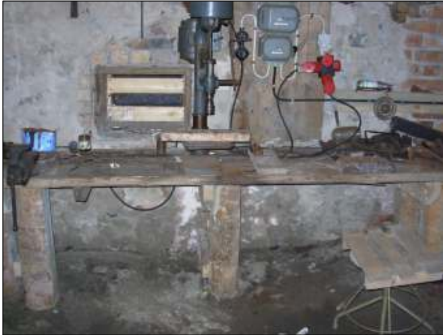
Södra ytterväggen före åtgärd
