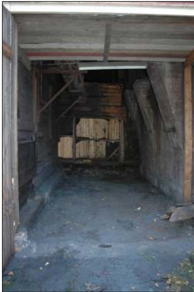
Golvet är urgrävt och delar av innerväggen är bortriven
