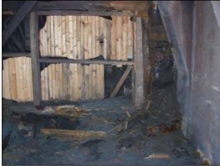
Del av innervägg är borttagen. Arbetet med att gräva ur det översta golvsiktet av slig återstår.
