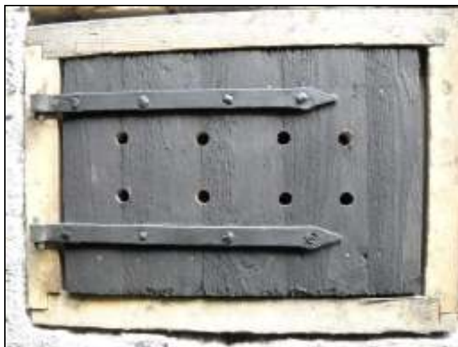
Fönsterlucka behandlad med slamfärg
