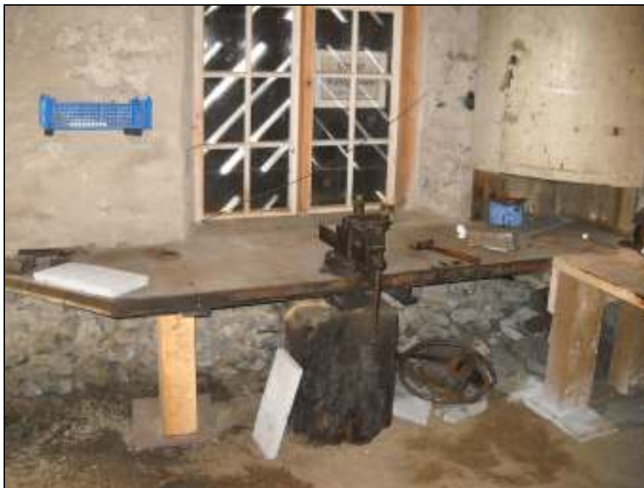
Östra ytterväggens arbetsbänk med nya ben på stenfundament. "Stubben" står kvar.
