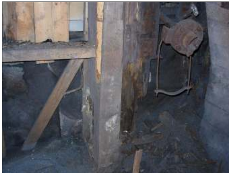
Arbete med rivning av innervägg pågår
