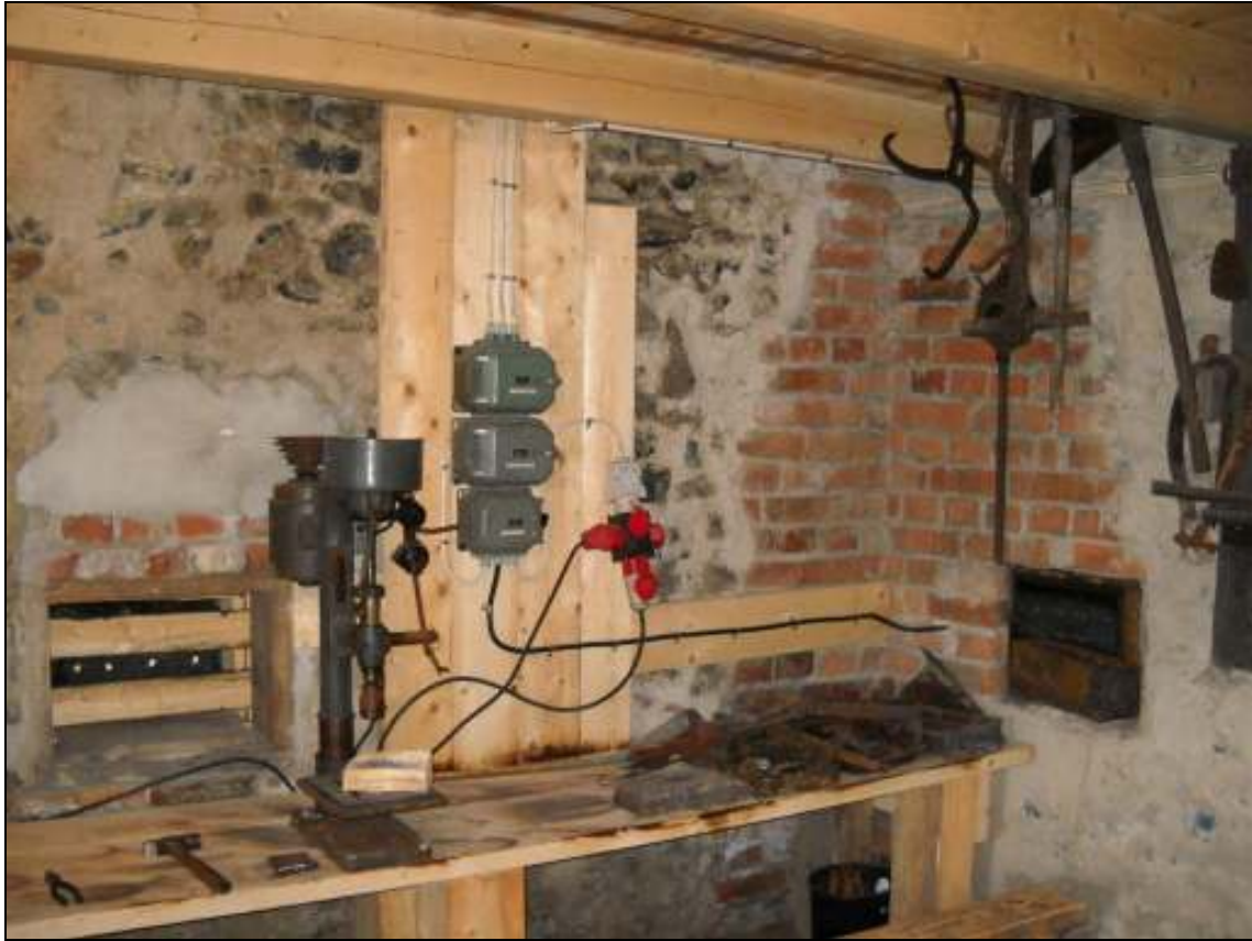
Väggen är putsad, ny panel är monterad, en ny arbetsbänk är på plats och träramen är av nytt trä
