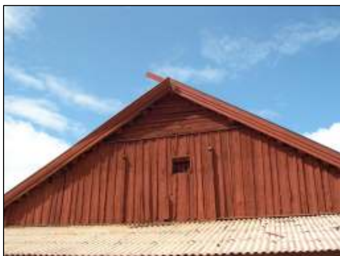
Arbete med vindskivor pågår på östra gaveln
