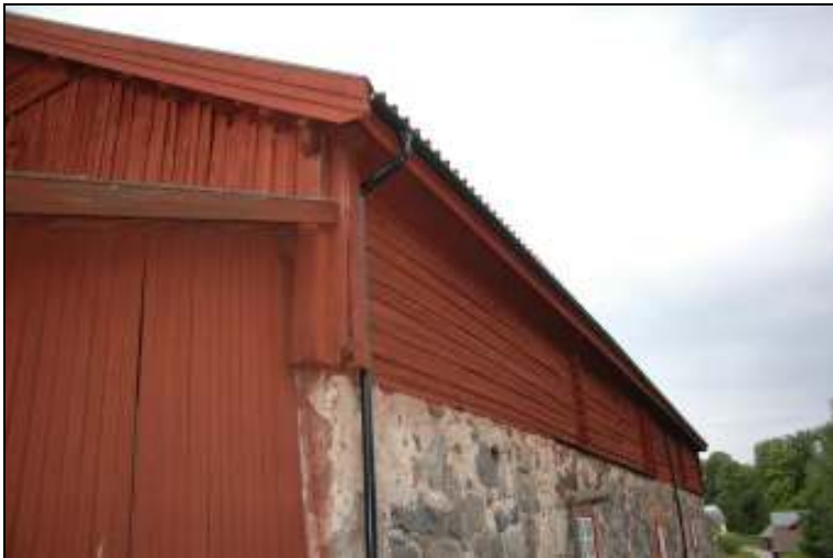
Nya rännor och stuprör på norra fasaden
