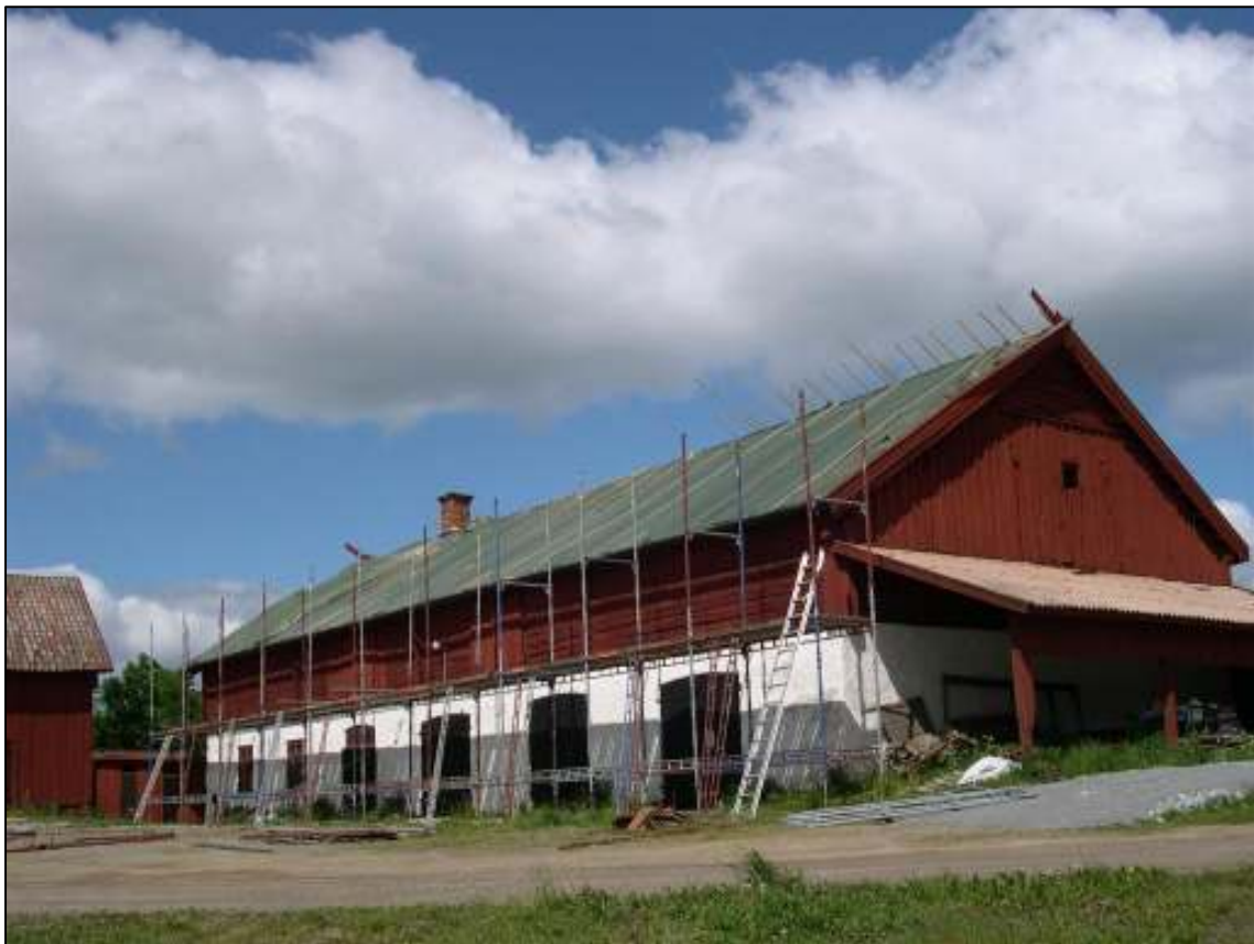
Arbete pågår med omläggning av tak på södra takfallet
