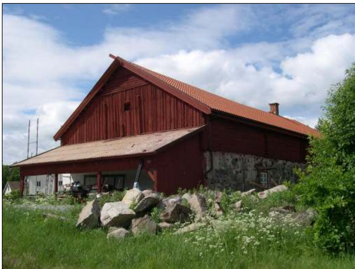
Östra gaveln samt del av norra fasaden och norra takfallet med taket omlagt Arbete med vindskivor pågår
