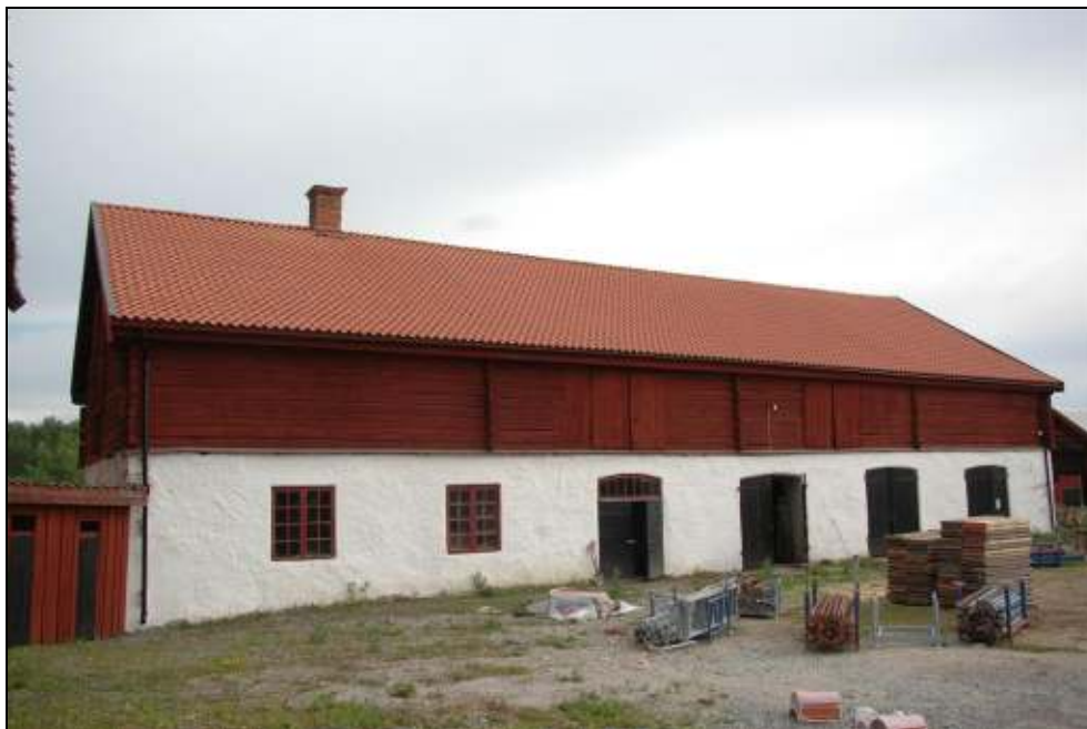
Södra fasaden efter åtgärd
