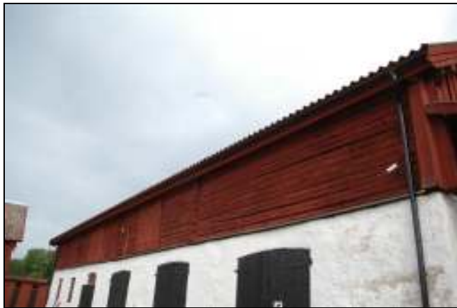
Södra fasaden efter åtgärd, endast rödfärgning av fotbräda återstår
