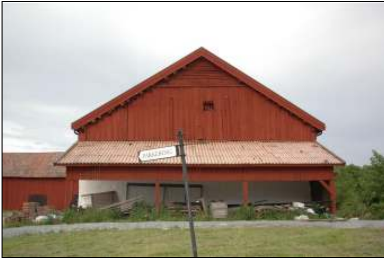
Östra gaveln efter åtgärd, nya vindskivor är uppsatta
