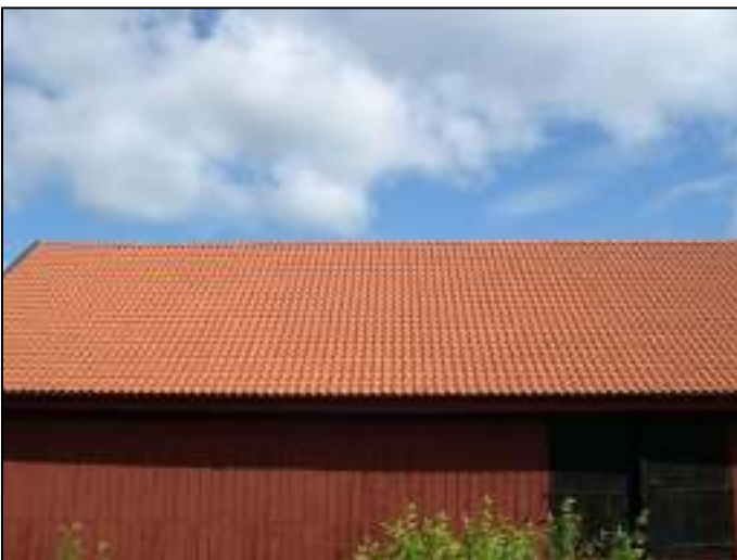
Norra takfallet efter åtgärd
