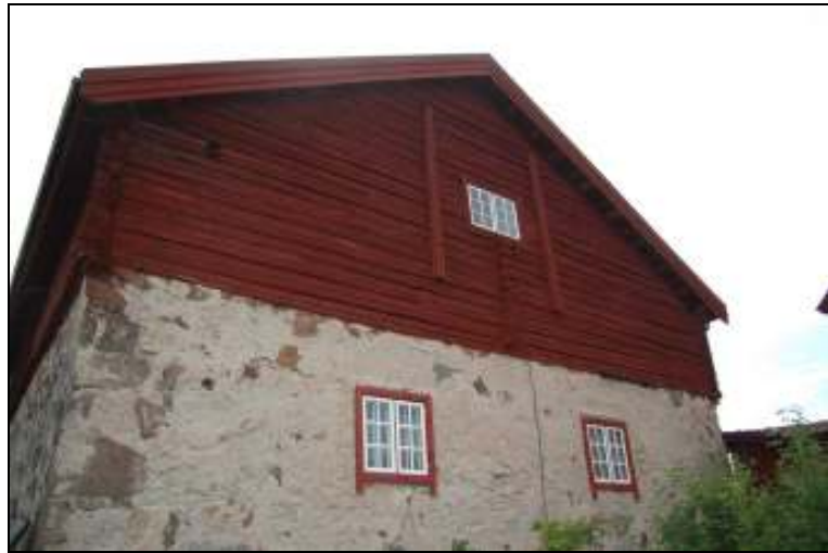
Västra gaveln efter åtgärd, nya vindskivor är uppsatta
