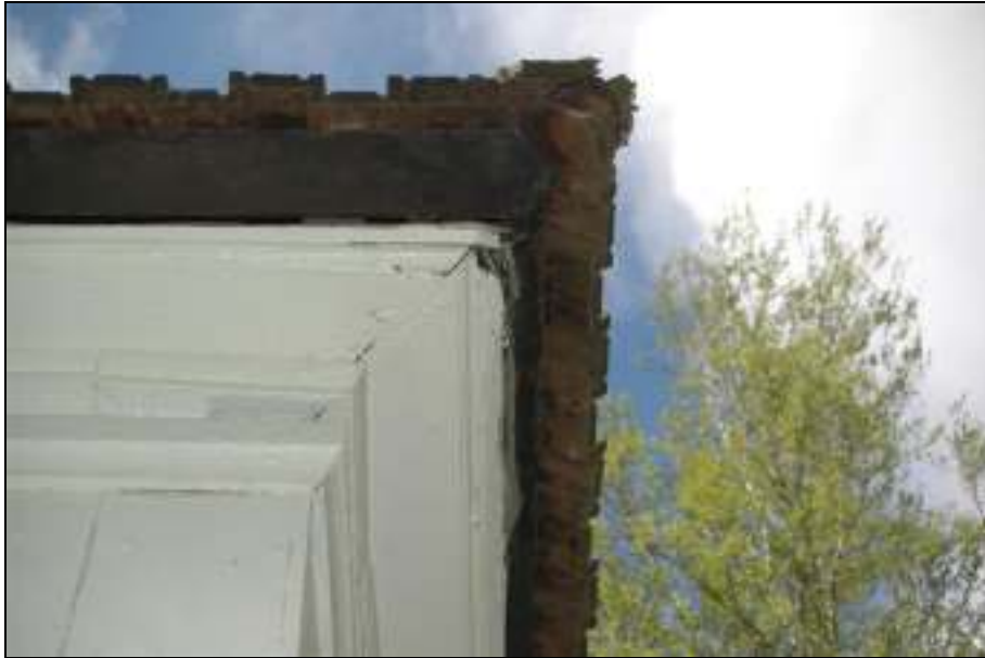
Takfot före åtgärd
