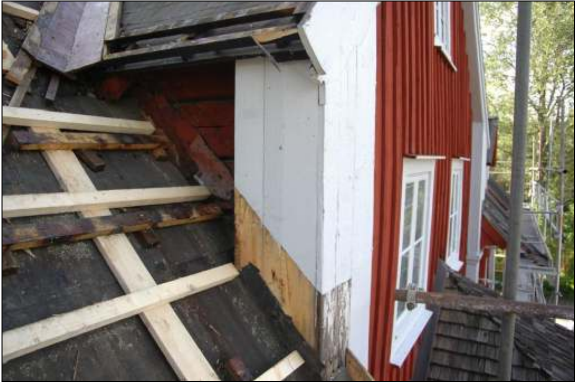
Arbete vid frontespis pågår
