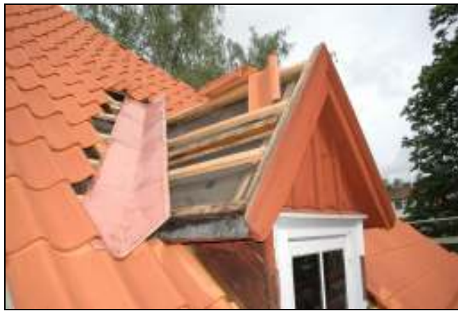
Ny räändal av kopparsplåt är monterad
