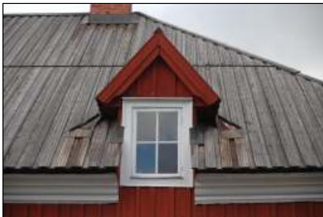
Takkupa före åtgärd
