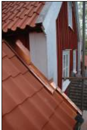
Frontespis efter åtgärd
