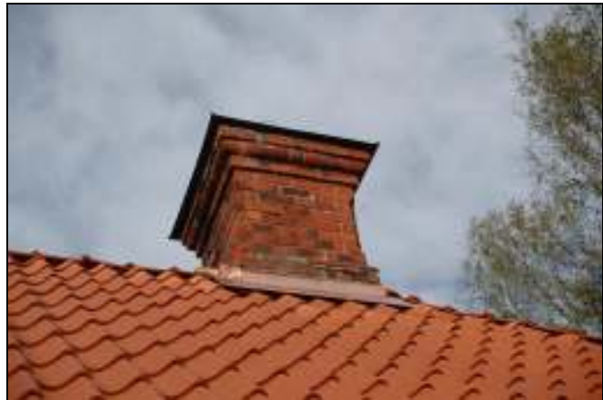
Skorsten med nya plåtar av koppar
