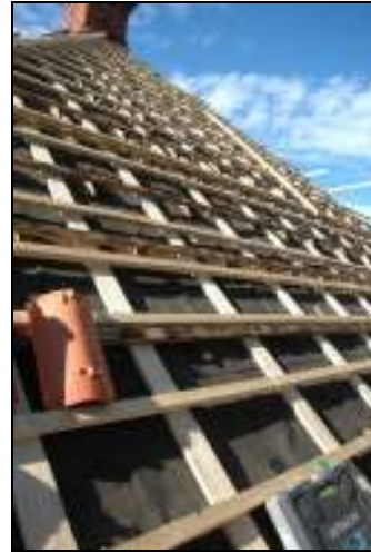
Takfallet redo för läggning av tegel
