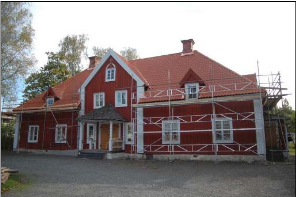
Nordvästra sidan efter åtgärd, endast montering av ändnockpanna återstår
