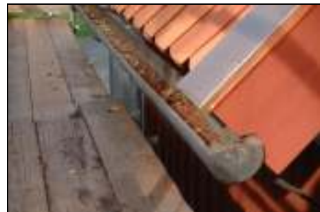
Takfot vid träränna efter åtgärd
