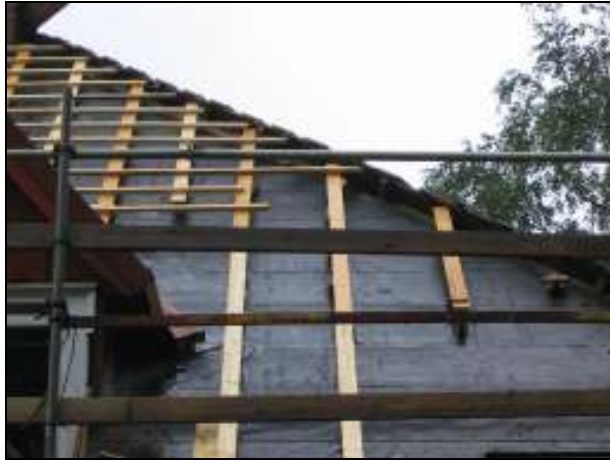
Arbete med läkt och papp pågå
