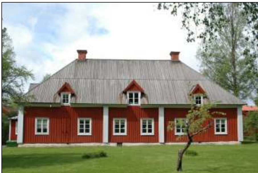
Sydöstra sidan före åtgärd
