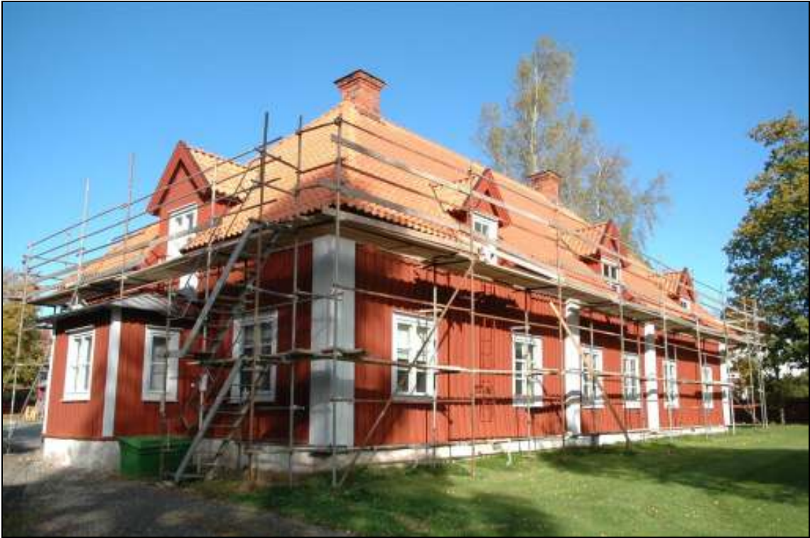
Sydvästra gaveln och sydöstra sidan efter åtgärd
