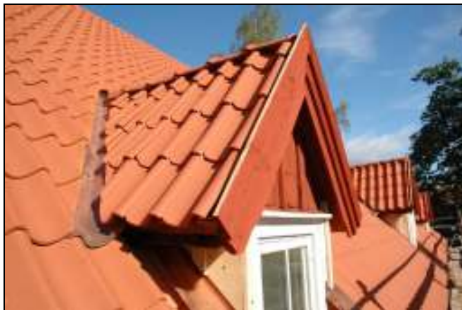
Takkupan nästan färdig, avfärgning av panel och montering av vattbräddor återstår
