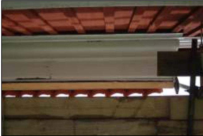
Teglets montering vid takfot sett underifrån
