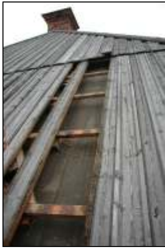
Nedtagning av faltak pågår
