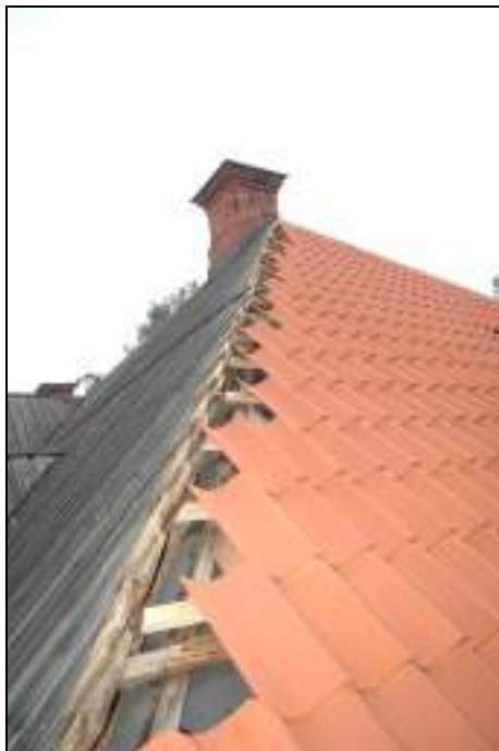
Läggning av tegel pågå
