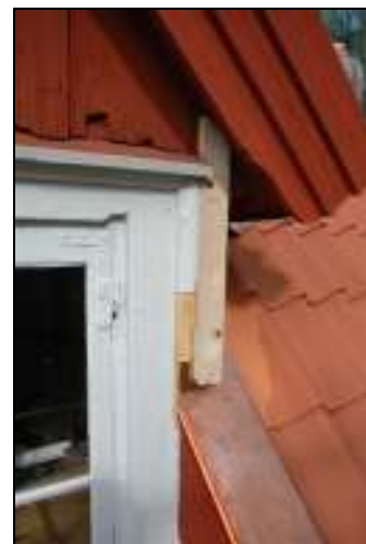
Takkupa kompletterad med "pusselbitar" av nytt virke
