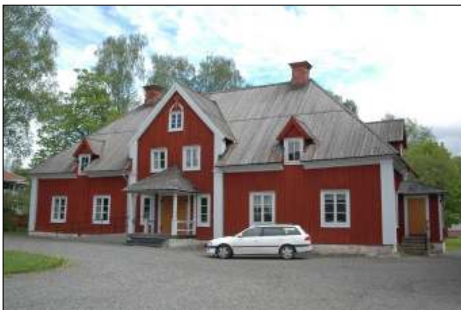
Nordvästra sidan före åtgärd
