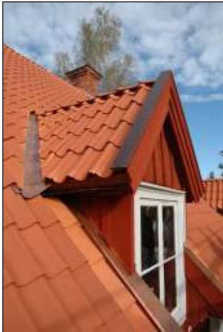
Takkupa efter åtgärd
