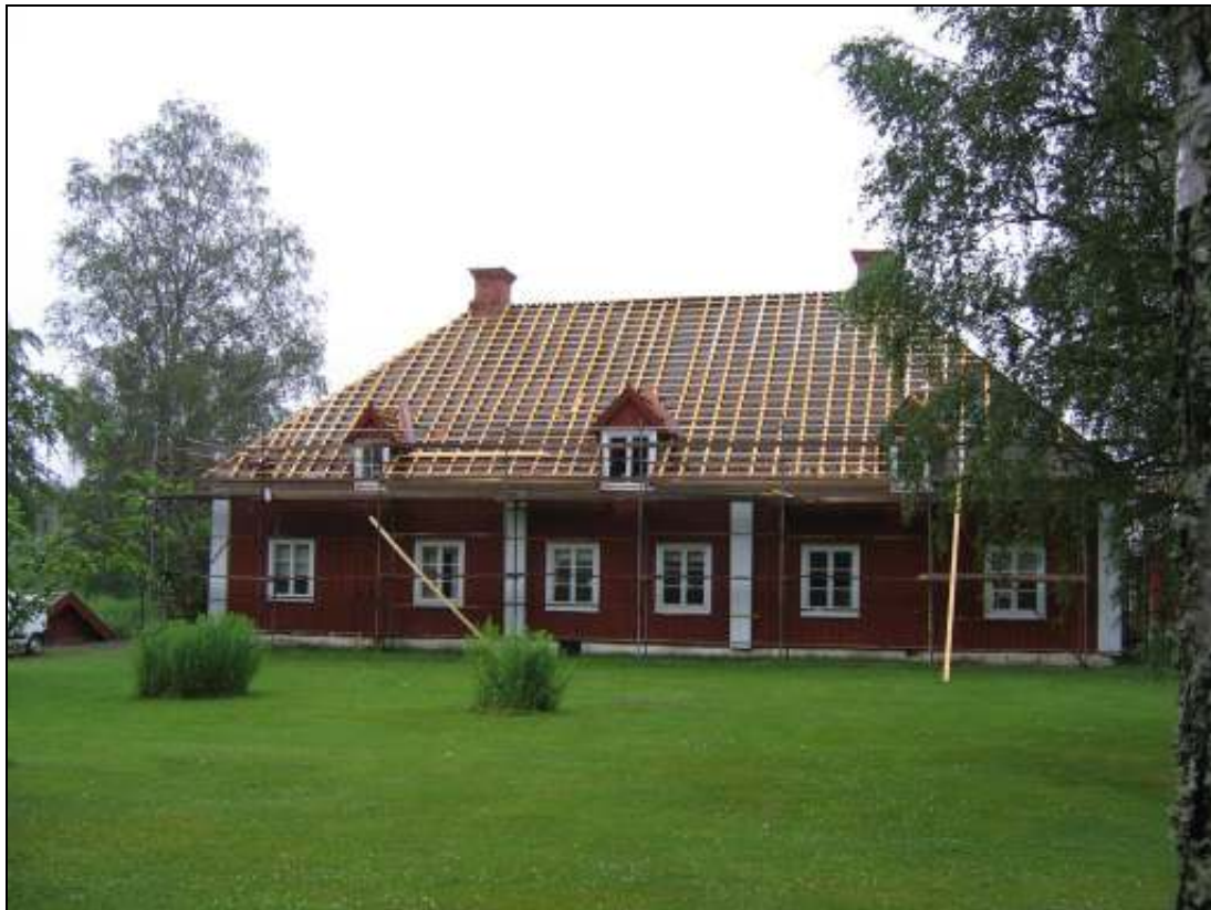
Komplettering av läkt på sydöstra takfallet pågår
