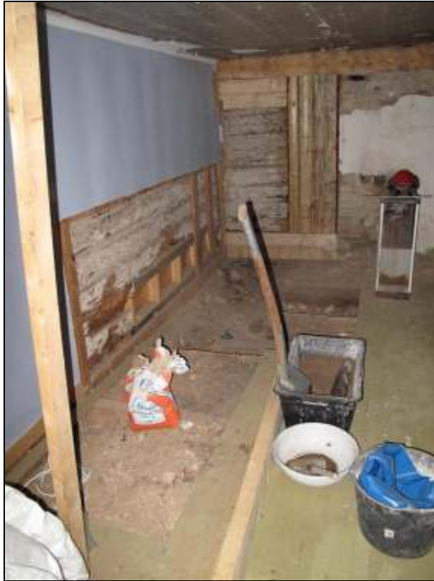
Mellanväggen efter åtgärd. Arbeten med bl a golv och yttervägg återstår
