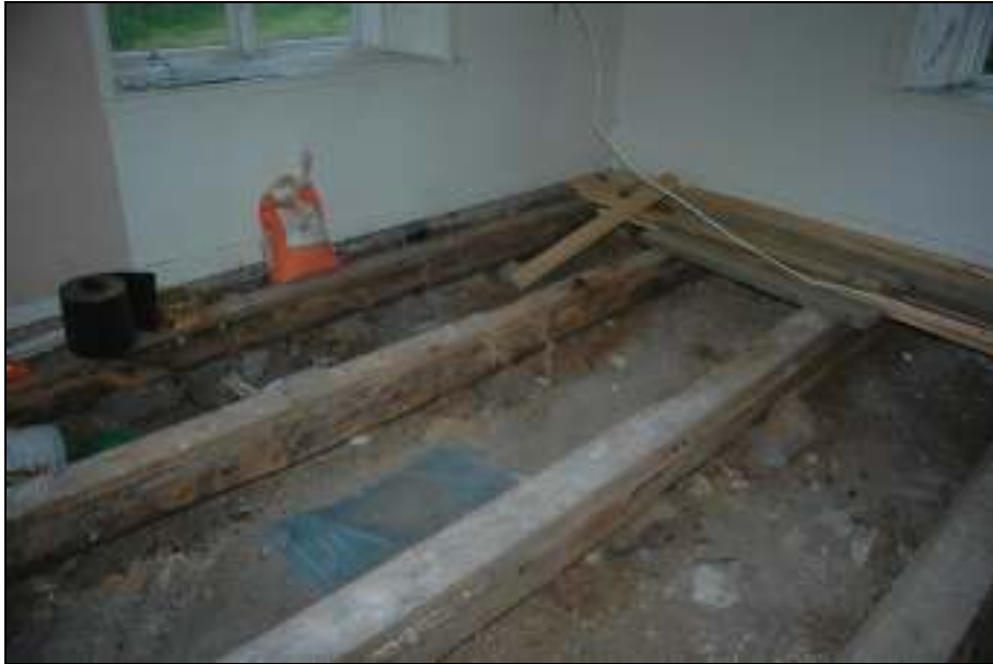
Golvbjälklaget i köket
