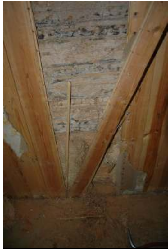
Timmerväggen har tidigare varit lerklinad
