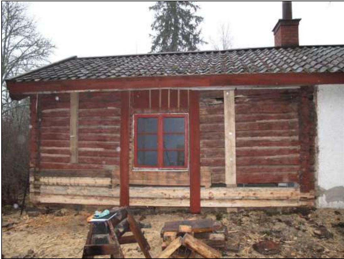
Norra fasaden har kompletterats med nytt timmer
