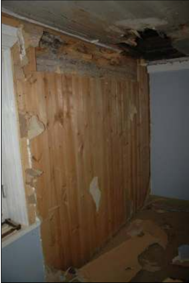
Friläggning av norra ytterväggen pågår
