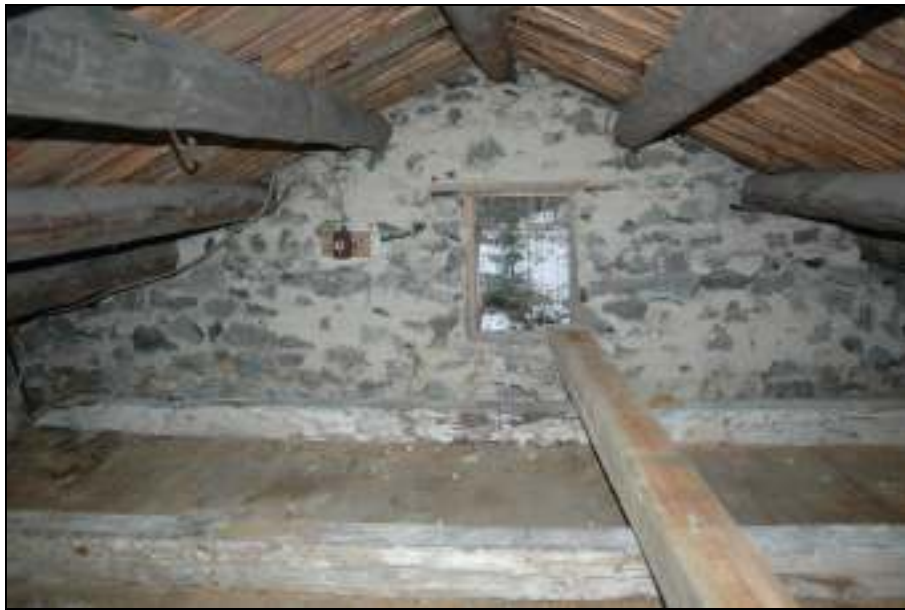
Isoleringsmaterialet är avlägsnat
