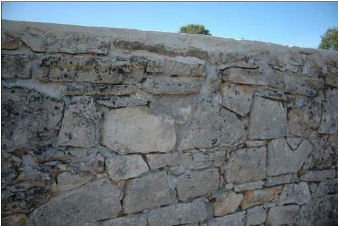
Putshyllan är gjuten
