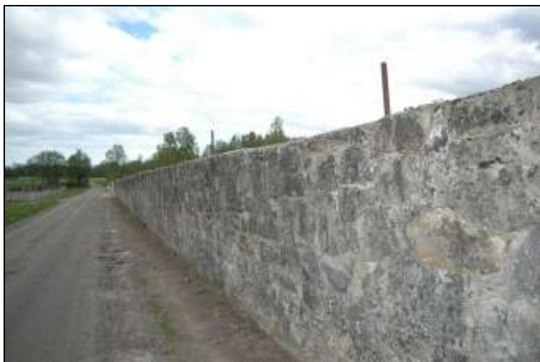
Västra murens norra sida före åtgärd
