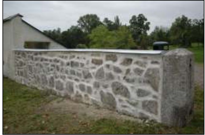
Västra murens norra sida efter åtgärd
