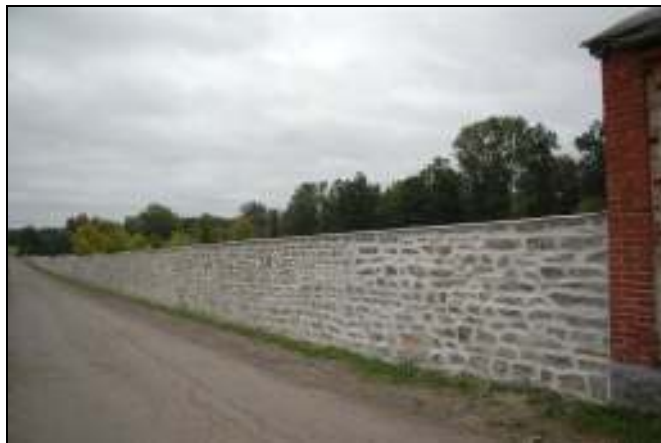
Västra murens norra sida efter åtgärd
