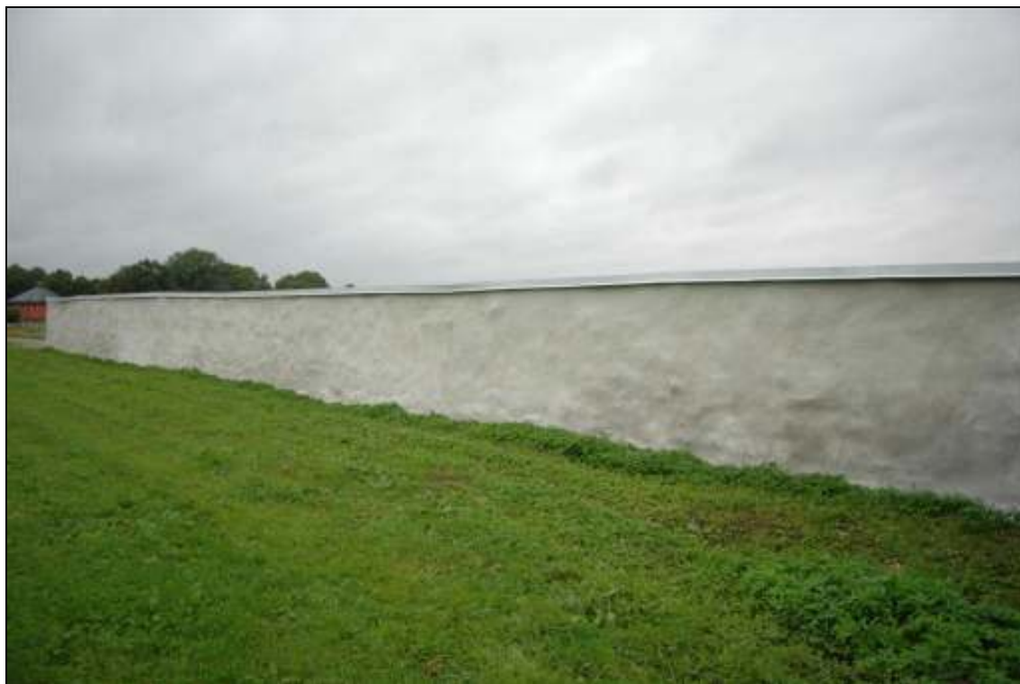
Östra murens södra sida efter att frostskadorna har lagats
