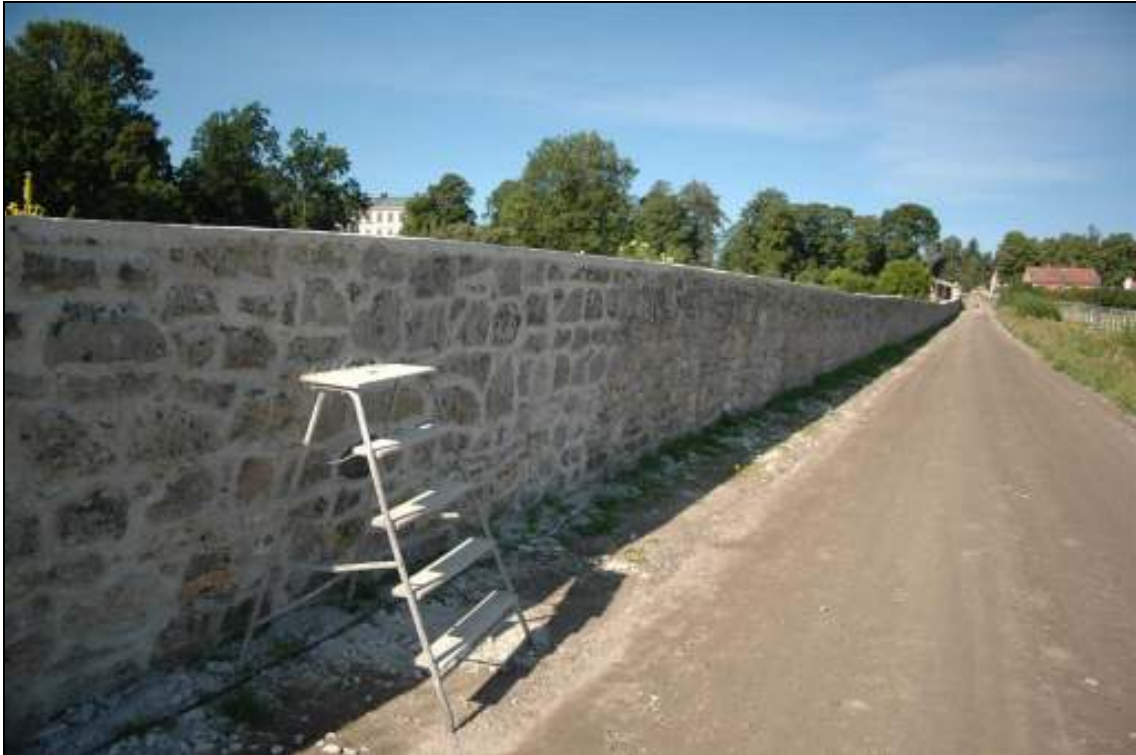
Omfogning av västra murens norra sida pågår
