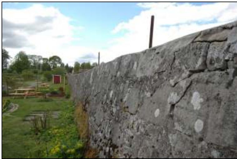
Västra murens södra sida före åtgärd
