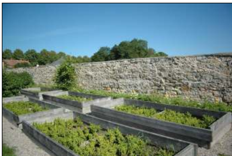
Västra murens södra sida efter att cementputsen bilats bort
