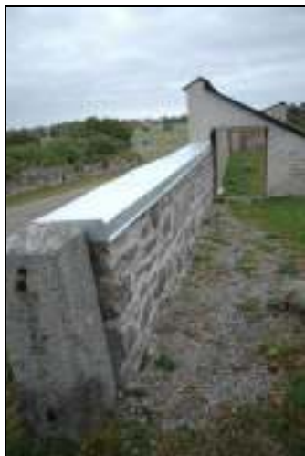
Västra murens södra sida efter åtgärd
