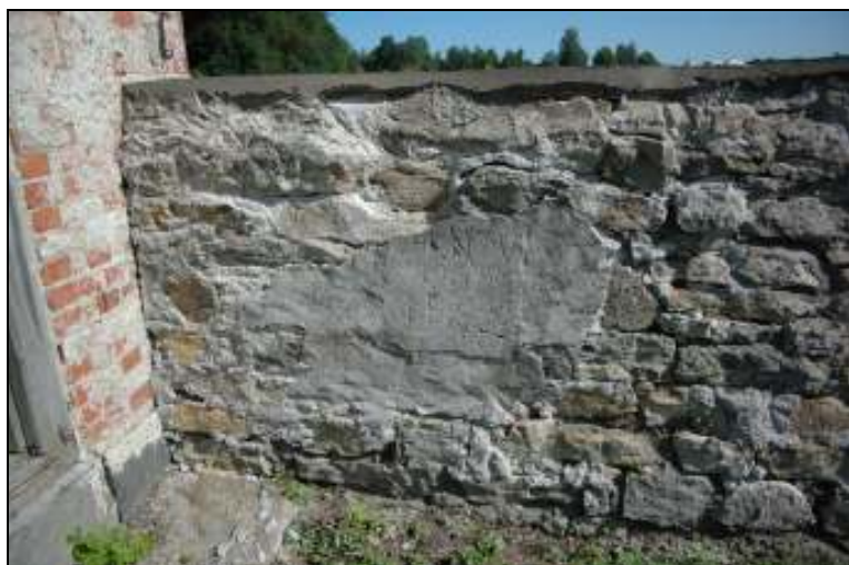
Inskriptionen på västra muren efter att omgivande cementputs avlägsnats
