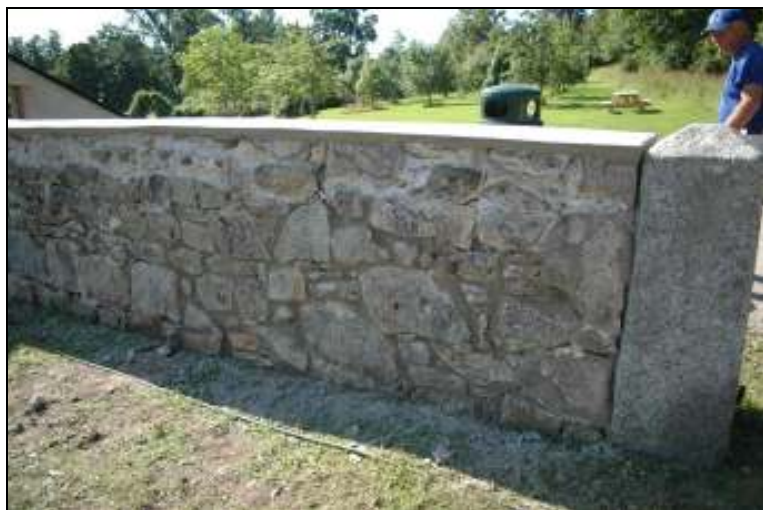
Putshyllan är gjuten och omfogning av murverk är utförd
