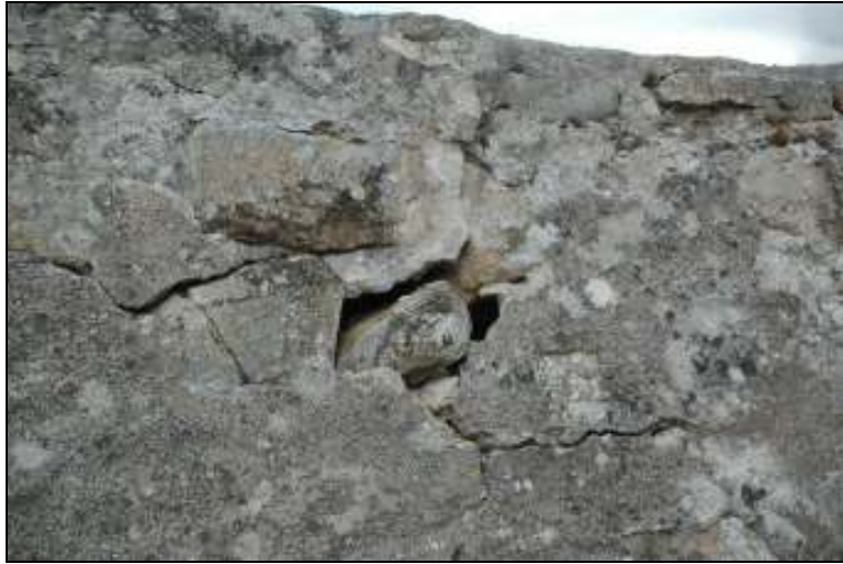
Västra murens södra sida före åtgärd
