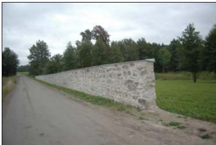
Östra murens norra sida efter åtgärd
