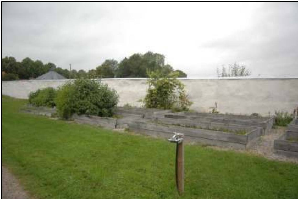
Västra murens södra sida efter åtgärd
