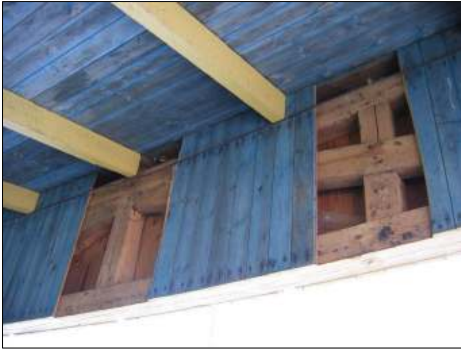
Nedtagning av befintlig panel på insidan av fackverkskonstruktionen
