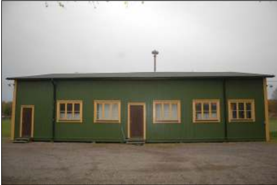
Läktarens baksida efter åtgärder
