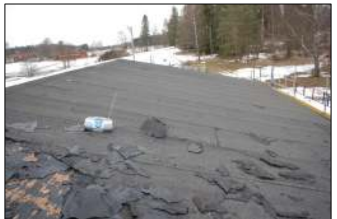
Borttagning av befintlig takpapp pågår
