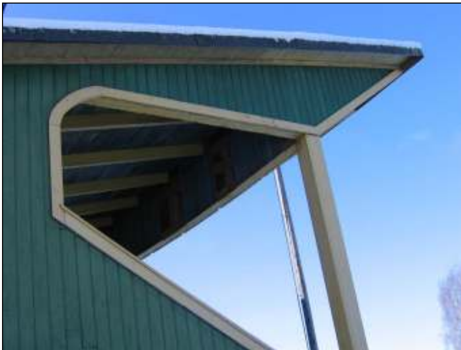
Del av läktaren före åtgärd
