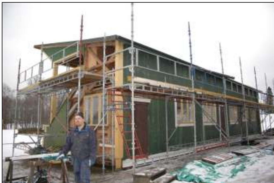
Delar av befintlig panel är borttagen respektive utbytt
