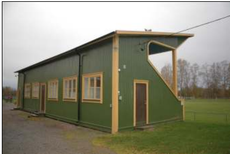
Läktaren efter åtgärder
