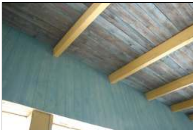
Ny, råspontad panel på insidan av fackverkskonstruktionen är monterad och avfärgad
