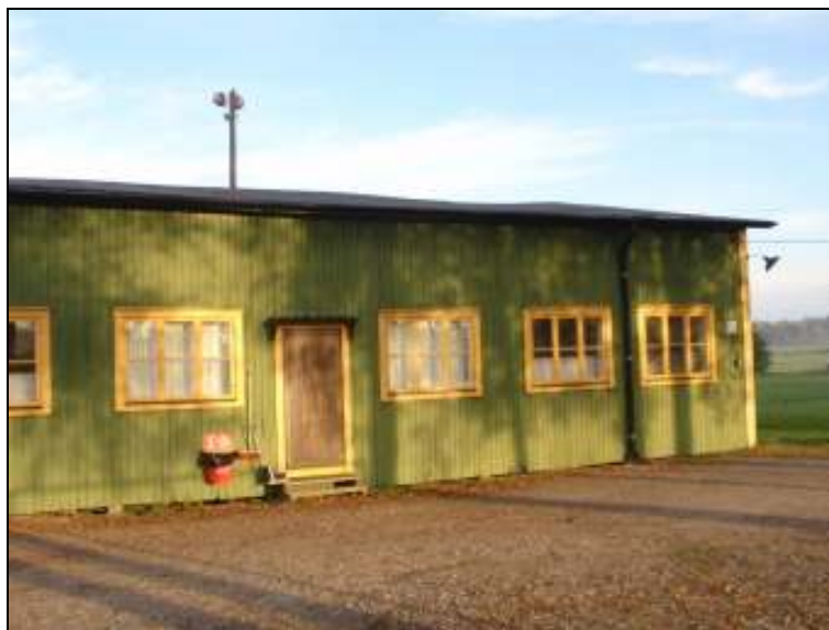
Läktarens baksida med omklädningsrum
