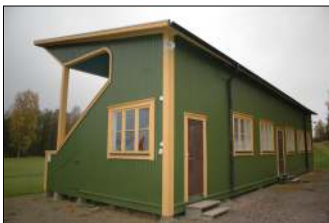
Läktaren efter åtgärder
