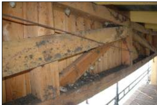
Fackverkskonstruktionen blottlagd
