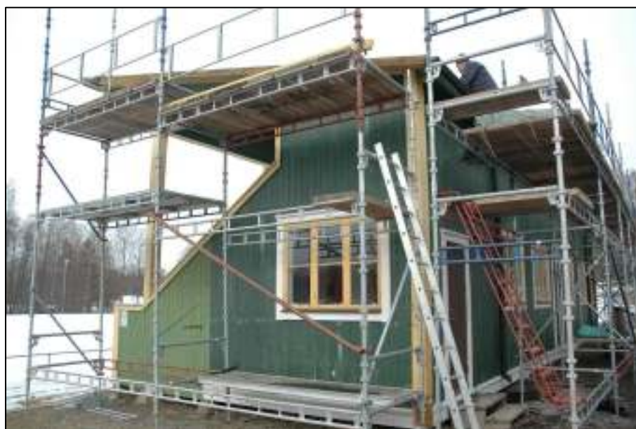
Fönstren har fått nya foder och panelen har skarvats
