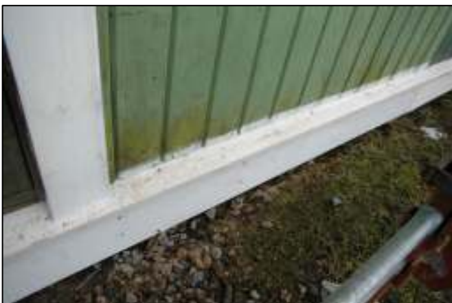
Panelen har skarvats med vattbräda
