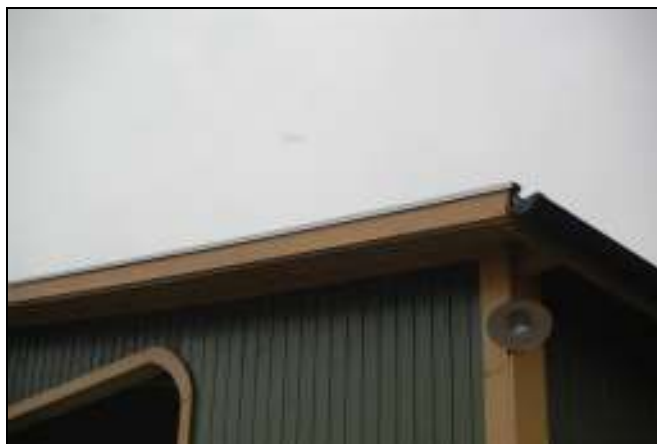
Ny vindskiva med plåtavtäckning är monterad
