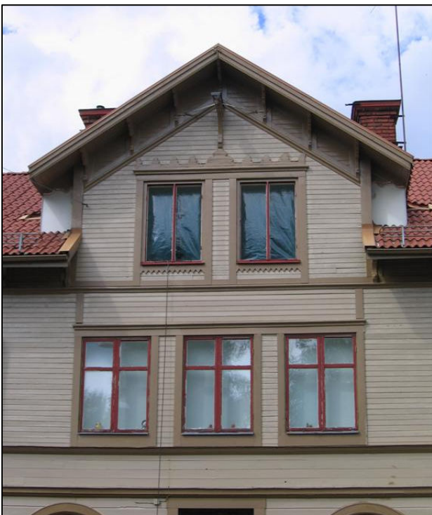
Den södra fasaden efter åtgärder.
