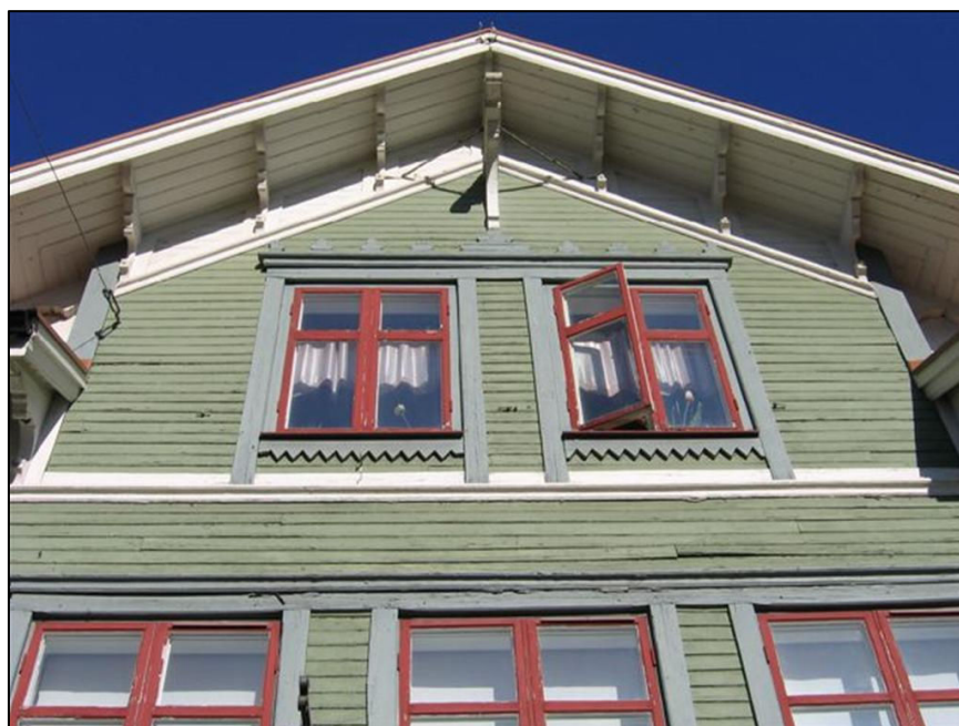
Den södra fasaden före åtgärder.
