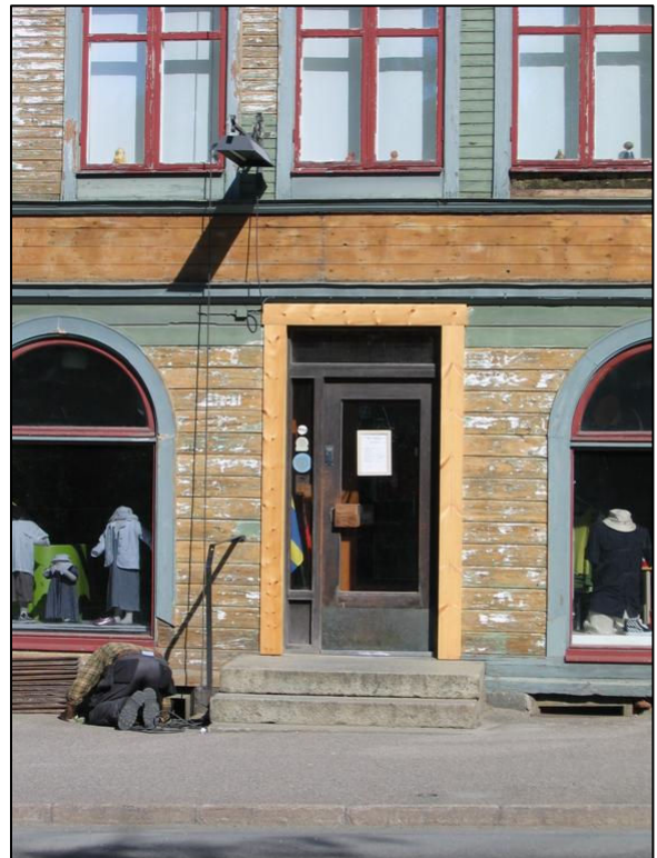
Dörren på södersidan har fått nya dörrfoder.
