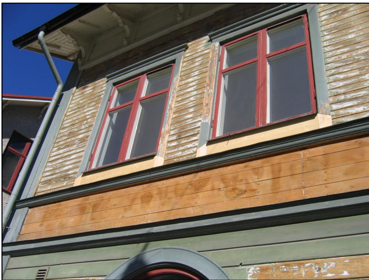
Övervåningens fönster har delvis fått nya fönsterfoder. Masonitskivorna avlägsnades mellan de profilerade listerna.
