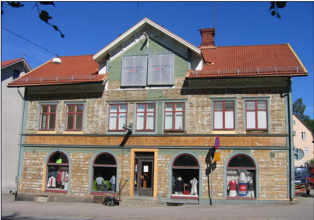
Den södra fasaden under arbetets gång.
