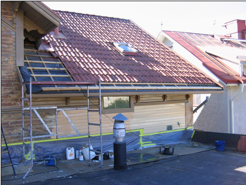
Målningsarbete pågår på den norra fasaden.
