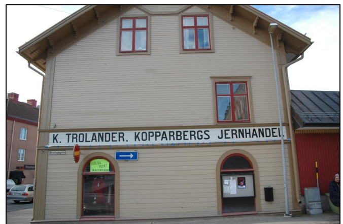
Den östra fasaden efter åtgärder.
