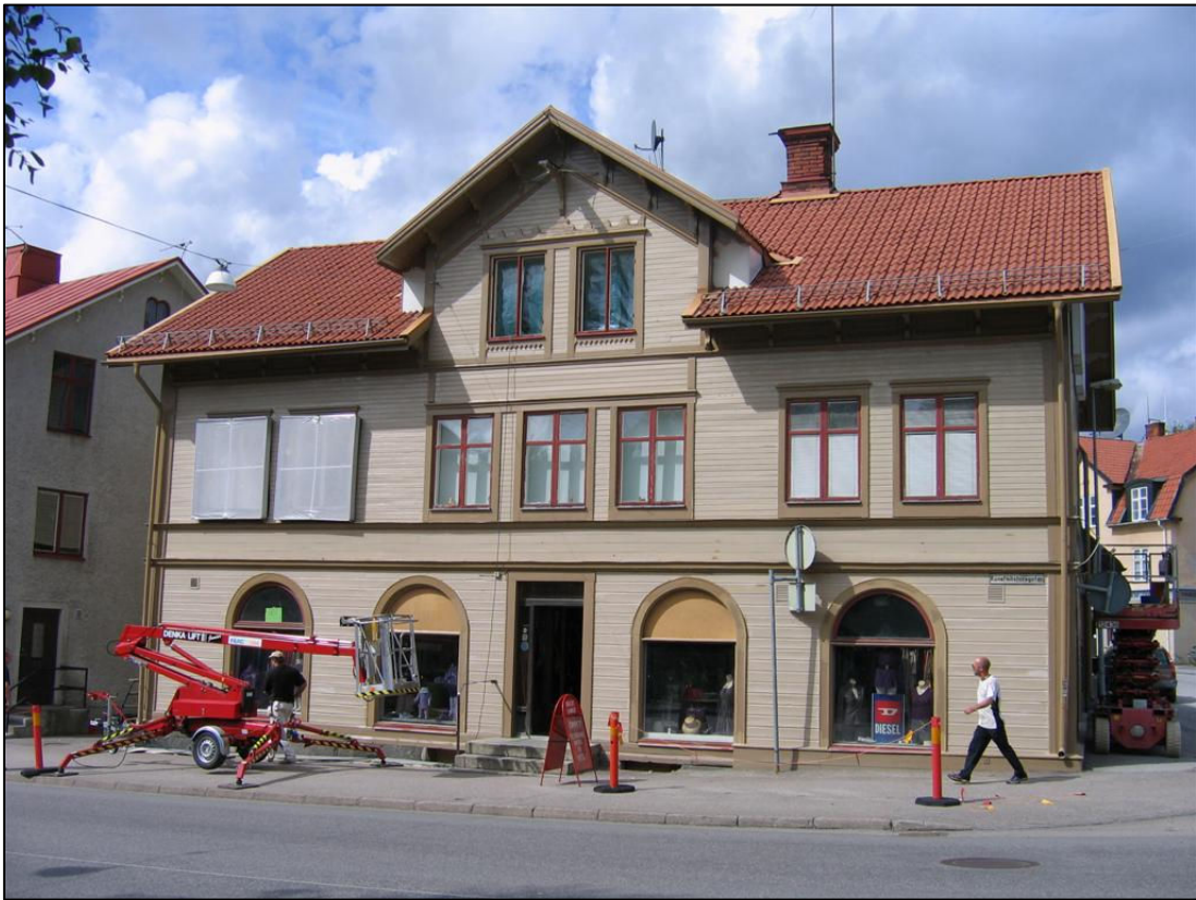
Den södra fasaden efter åtgärder. Endast några fönsterbågar ska sättas på plats.
