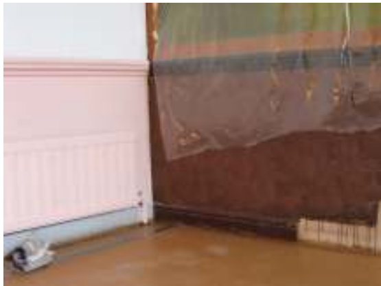
Bild 8: Grundmålning av bröstning på korets norra vägg.
