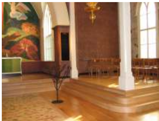
Bild 5: Efter renoveringen, golvet är sänkt och sidogradängen har försetts med trappa.
