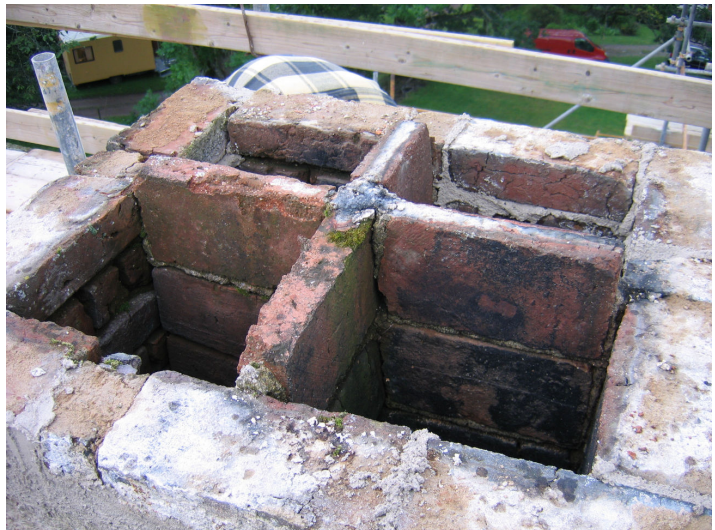
Arbetet med att renovera skorstenarna pågår.
