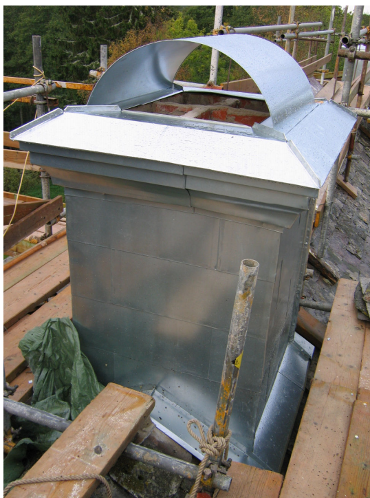
Skorstenarna efter renovering med ny plåtinklädnad.
