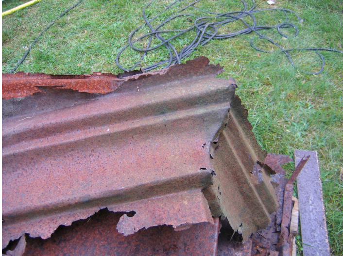
Plåtinklädnad från byggnadens skorstenar.
