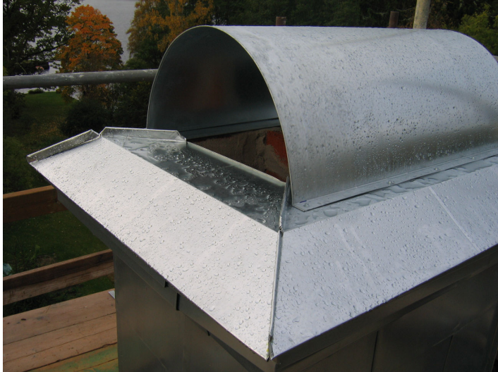
Skorstenarna efter renovering med ny plåtinklädnad.
