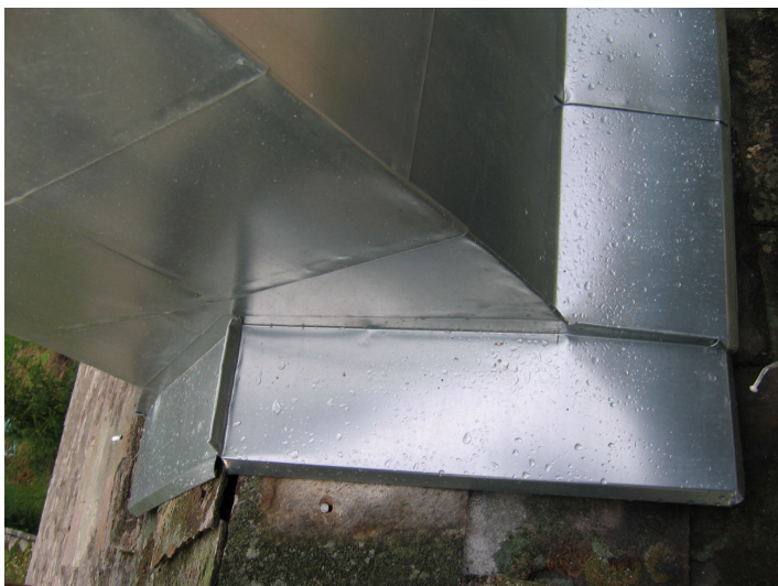
Skorstenarna efter renovering med ny plåtinklädnad.
