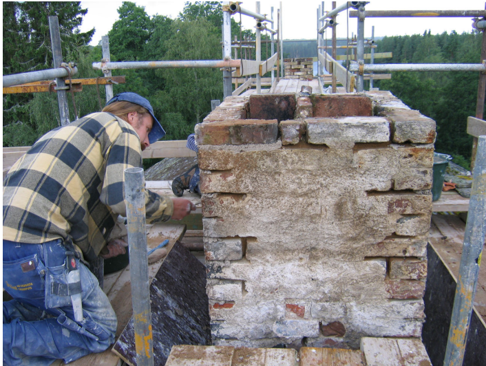
Arbetet med att renovera skorstenarna pågår.
