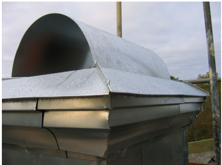
Skorstenarna efter renovering med ny plåtinklädnad.
