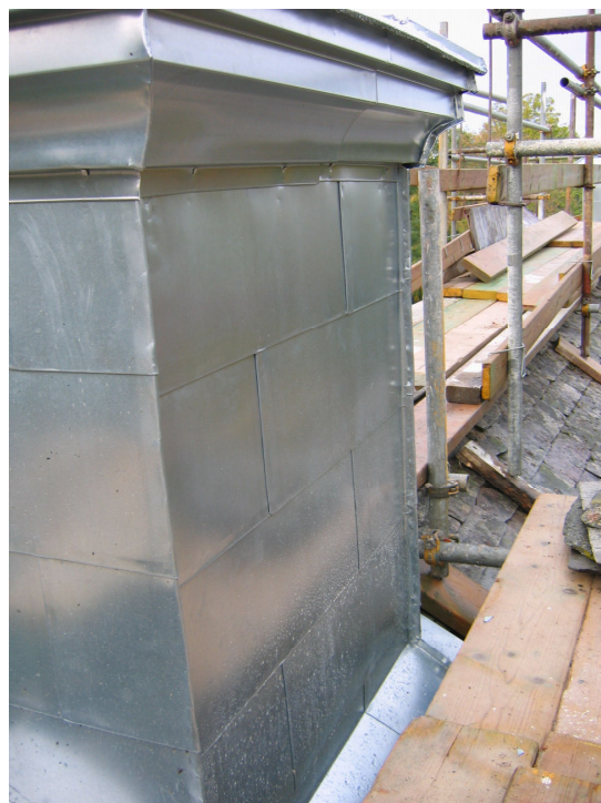
Skorstenarna efter renovering med ny plåtinklädnad.
