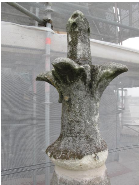
Bild till vänster: Befintlig korsblomma med kraftig vittring, sydvästra hörntornet. Bild till höger: Kopia av sydvästra tornets korsblomma under tillverkning.
