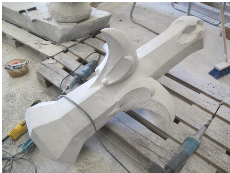
Bild till vänster: Befintlig korsblomma med kraftig vittring, sydvästra hörntornet. Bild till höger: Kopia av sydvästra tornets korsblomma under tillverkning.
